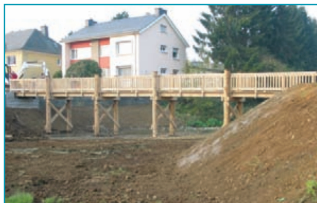
Aménagement d'un pont sur pilotis sur la Chiers qui s'adapte écologiquement et hydrauliquement au milieu humide.
