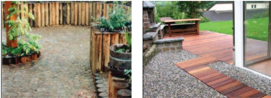
Bild 4.5: Kiesbelag in Kombination mit Holzrosten (links; Burkis, 2007) und Holzpflaster zur Flächenbefestigung (rechts; Hansel, 2007)
