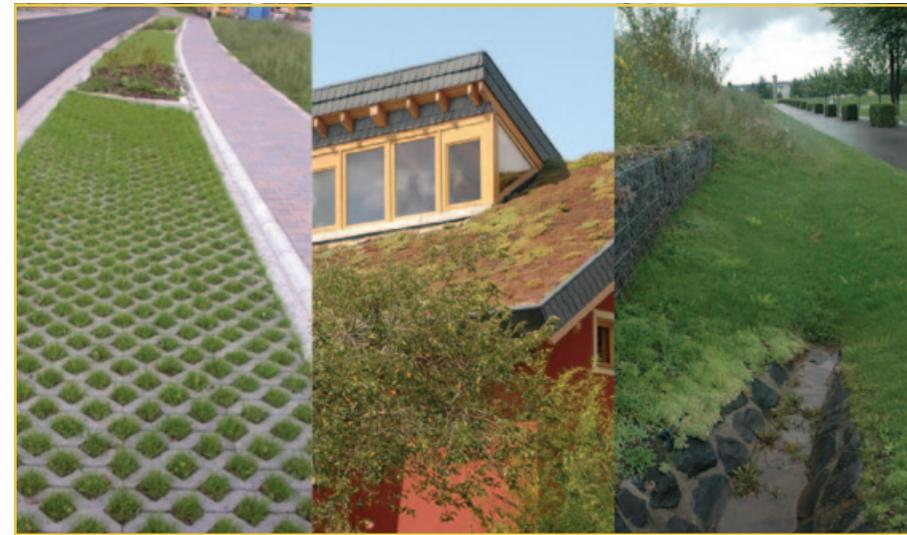
*Bild 2.5: Beispiele für Maßnahmen zur Entsiegelung (durchlässiger Flächenbelag, links) sowie zur Rückhaltung und verzögerten Ableitung (Gründach und offene Rinne, Mitte bzw. rechts)*
