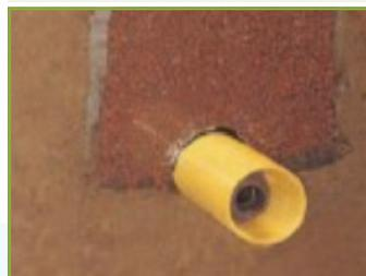
Bild 4.16: Mulden-Rohrrigolen-Element im Querschnitt (MURL-NRW, 1998)
