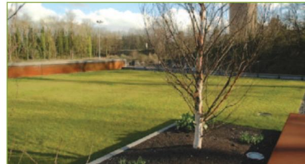
*Bild 4.24: Intensiv begrüntes Flachdach eines Industriegebäudes der SOTEG S.A. in Esch-sur-Alzette*
