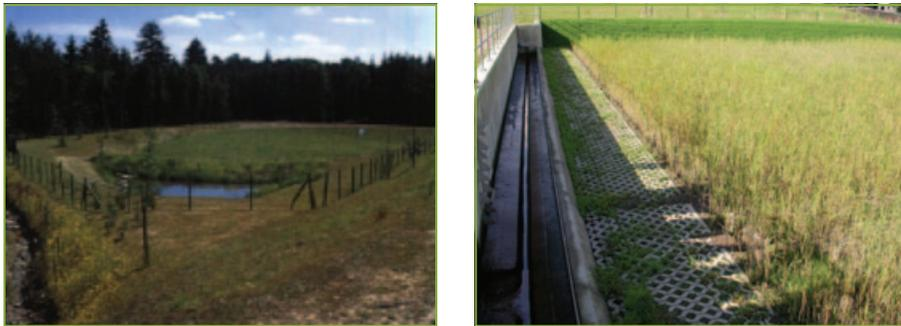
Bild 4.39: Retentionsbodenfilter vor Inbetriebnahme (links) (LfUMN BW, 2002), Schilfbepflanzung eines Retentionsbodenfilters im Anwuchsstadium (rechts)
