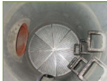
Bild 4.38: Zeolithische Filtereinheit (Athanasiadis et al., 2006)
