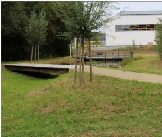
Ein Großteil des Regenwassers wird in Richtung Norden des Schulkomplexes geleitet, wo es, in mehrere Wiesenmulden gepuffert, der Alzette zugeführt wird. Zusätzlich lädt ein Holzsteg mit Plattform als gestalterisches Element zum Verweilen ein.
