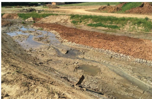
Pendant la phase chantier
