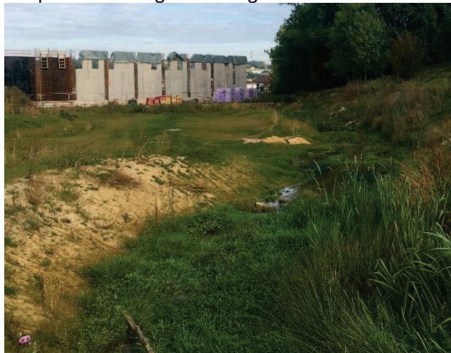
Zone de rétention - Bassin de crue
