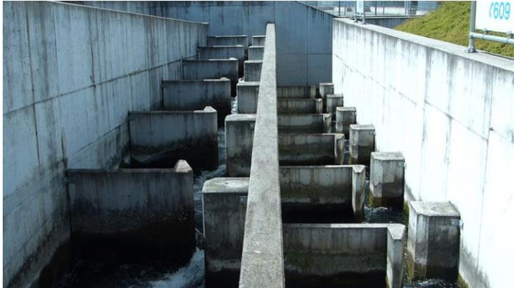
Abbildung 16: Schlitzpass: funktional, aber viel Beton und kein Lebensraum
