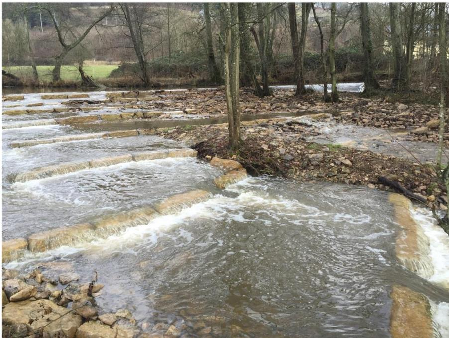
Abbildung 3: Beispiel einer Kontinuumssanierung bei einer Wehranlage mittels rauer Sohlrampe in Beckenform: Fausermillenan der Syre, Luxemburg (Länge der Rampe: 56 m, Höhe des Wehrs: 2,69 m, XY Koordinaten: 100.882 85.924); Bild oben: vor Sanierung; Bild unten: nach Sanierung (Foto: AGE).
