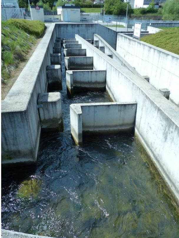
Abbildung 7: Beispiel eines Schlitzpasses bei Greinsfurth an der Ybbs, Österreich (Wehrhöhe 8 m, Schlitzbreite 40 cm, 58 Becken à 2,2 m × 3 m, Durchfluss 290 und 500 l/s).
