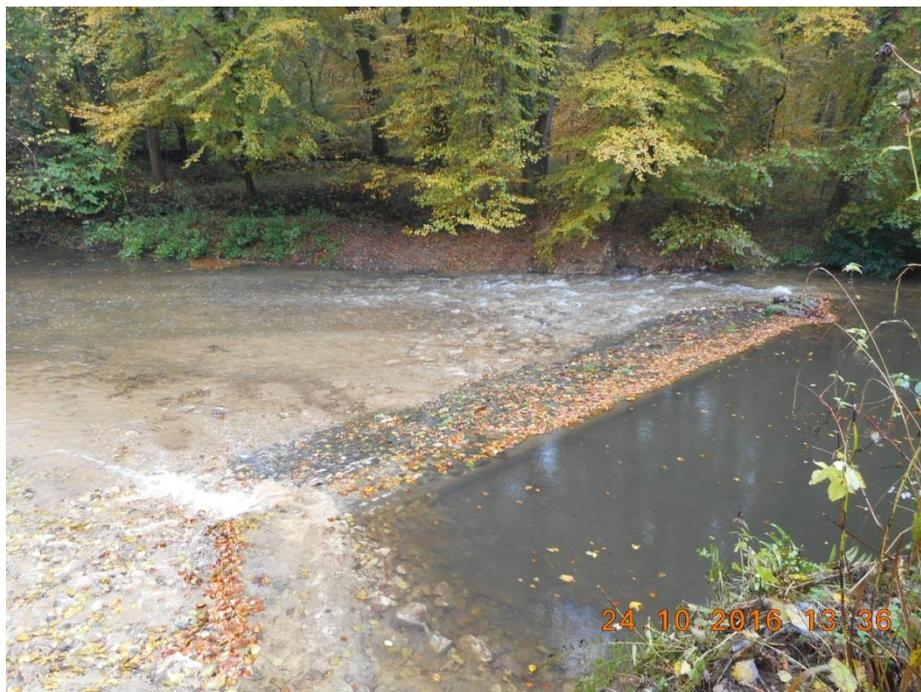
Abbildung 4: Beispiel einer Kontinuumssanierung bei einer Wehranlage mittels rauer Sohlrampe: Schankemillen an der Mamer, Luxemburg (Länge 20m, XY Koordinaten: 72.363 79.868); Bild oben: vor Sanierung; Bild unten: nach Sanierung (Foto: AGE).
