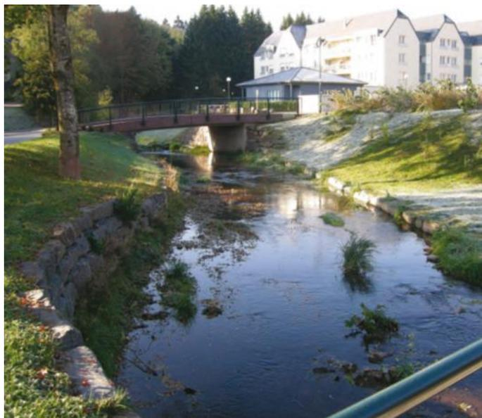
La section d'écoulement du cours d'eau dans la localité fut augmentée jusqu'à une largeur maximale de 13.5 m sur un linéaire de 180 m environ.
