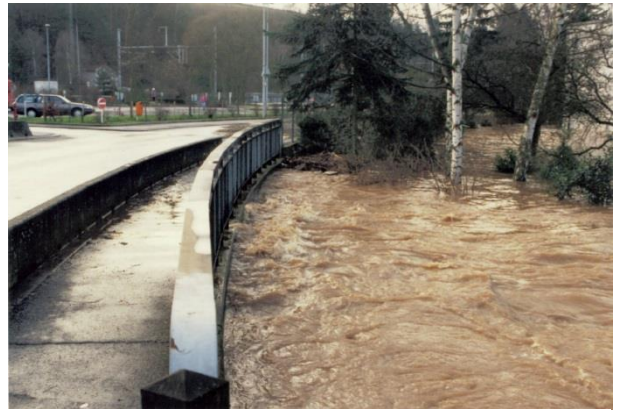
Abbildung 53: Hochwasser Januar 1995 in Ettelbrück
