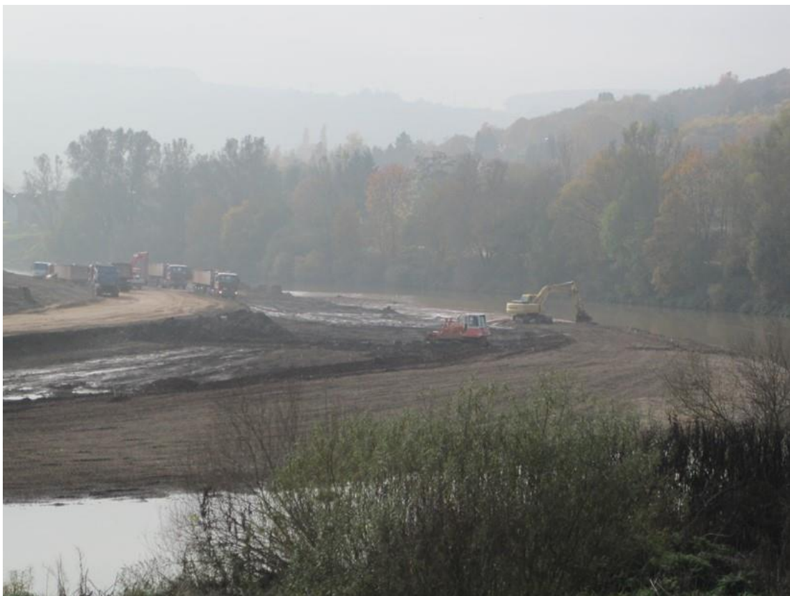
Abbildung 24: Ökologische orientierter Hochwasserschutz Ralingen-Steinheim während der Bauphase
