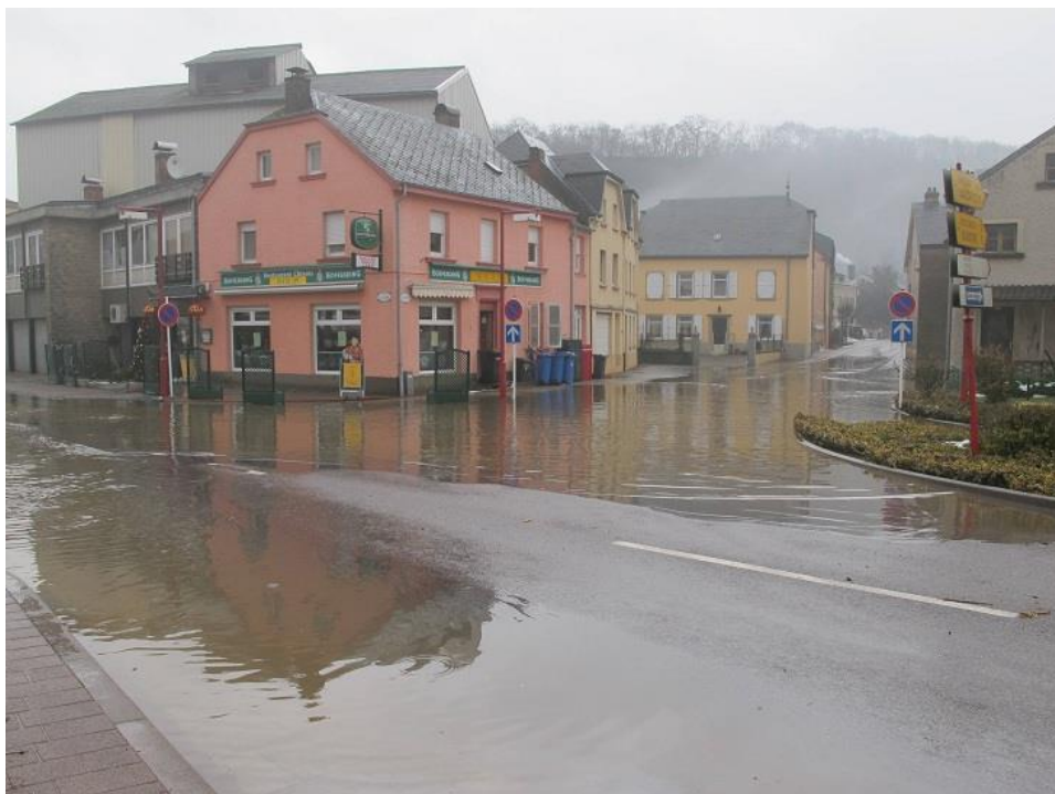
Abbildung 21: Hochwasser in Reisdorf (Sauer) am 07.01.2011
