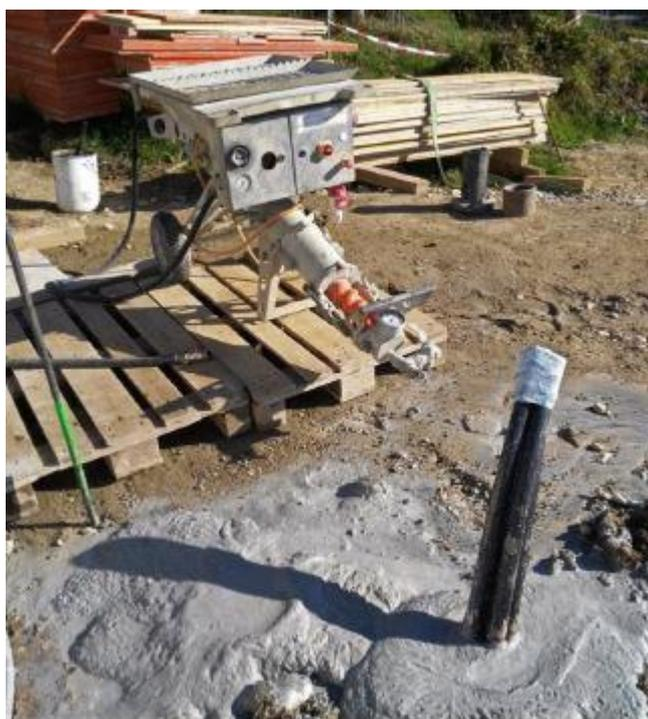
Figure 5-5: Cimentation complète du forage, le ciment est visible depuis la surface (Ebert, 2018).
