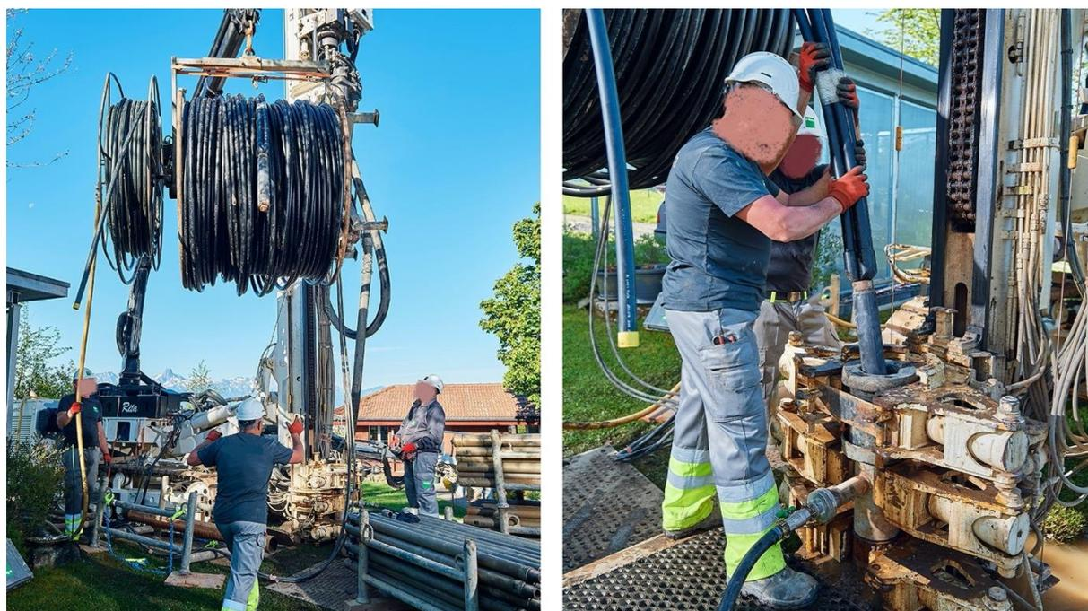
Figure 5-4: Exemple de la mise place d'une sonde dans le trou de forage. Le pied de la sonde est lesté (E-Therm, 2021).
