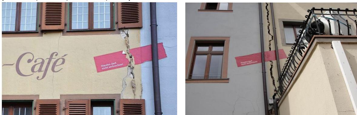
Figure 6-3: La transformation de l'anhydrite en gypse a entraîné une élévation de la surface et a causé des dommages sur des bâtiments à Staufen (BZ-Redaktion, 2019) (Risse Staufen, 2011).
