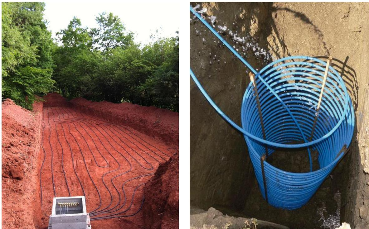
Figure 5-2: Exemple d'un capteur horizontal (gauche) et d'une corbeille géothermique (droite) (Altechgeothermie, 2021) (GeoClim, 2021).
