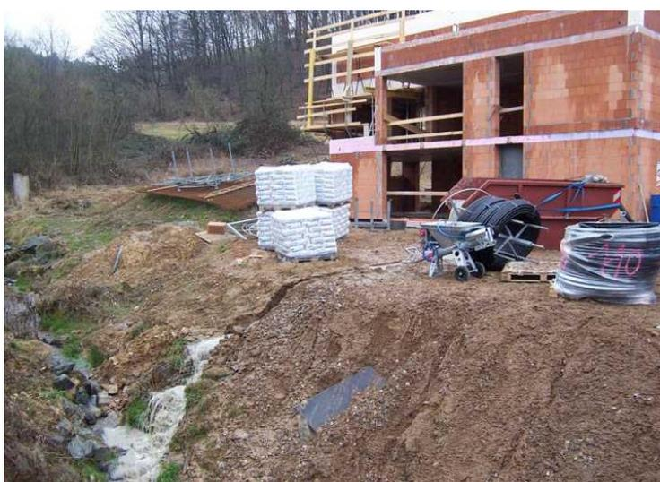
Figure 6-1: Pollution des eaux de surface par débordement de la benne de récupération des boues de forages.
