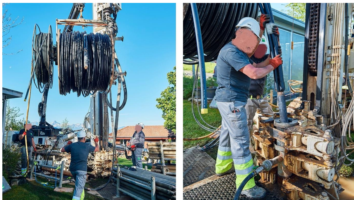
Figure 5-4: Exemple de la mise place d'une sonde dans le trou de forage. Le pied de la sonde est lesté (E-Therm, 2021).
