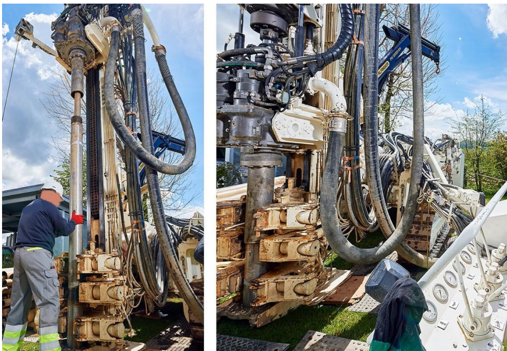
Figure 5-3: Exemple d'une réalisation d'un forage géothermique (E-Therm, 2021).
