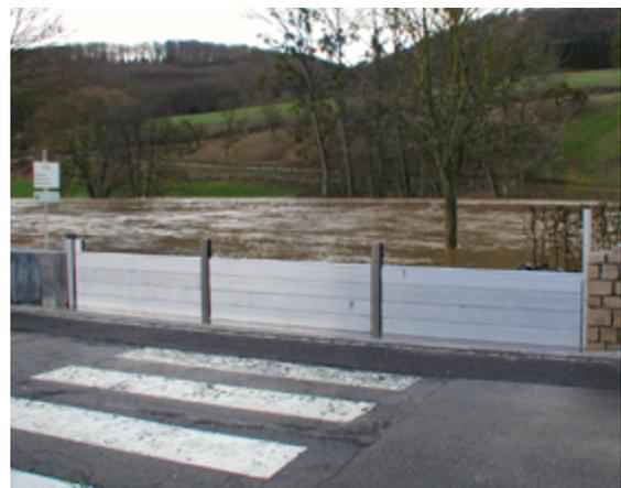
*Hochwasserschutzmauer mit mobilen Schutzelementen in Ingeldorf (oben) und Ettelbrück (unten)*
