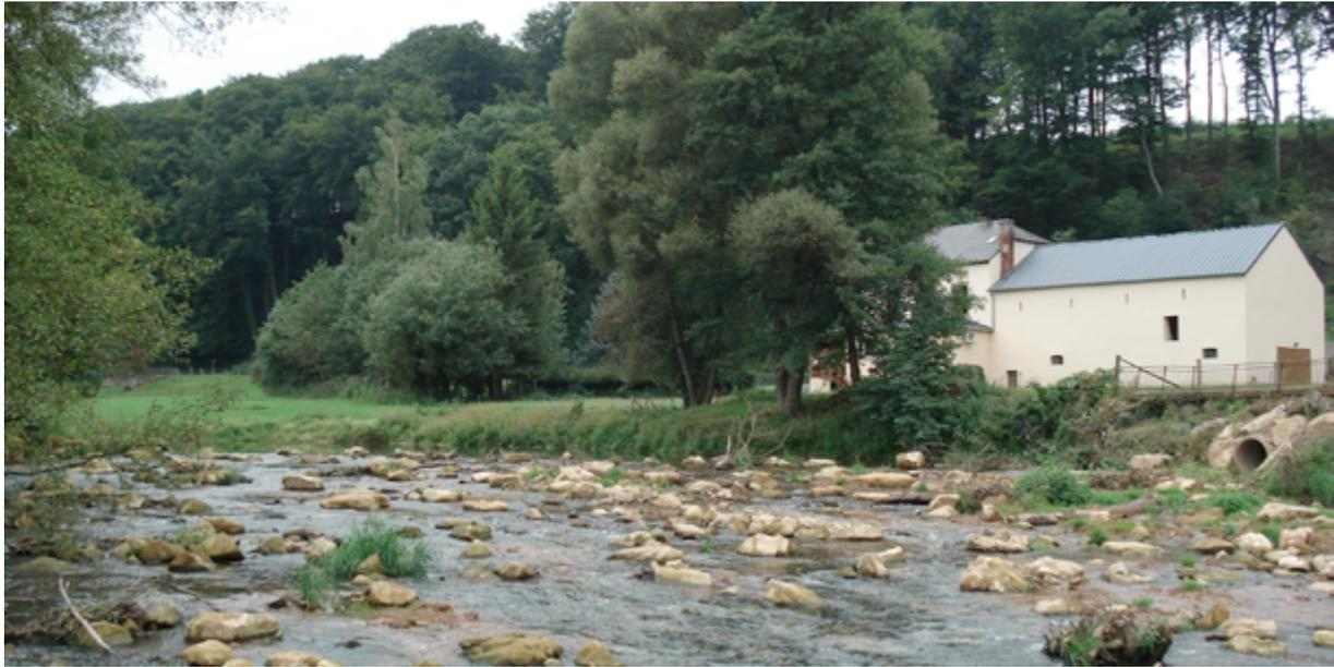
*Die Attert bei Boevingen/Attert. Hier wurde das bestehende Wehr in eine Fischrampe mit schwachem Gefälle umfunktioniert. Der Fischaufstieg kann somit wieder über die ganze Breite des Fließgewässers erfolgen. (Baujahr 2008)*
