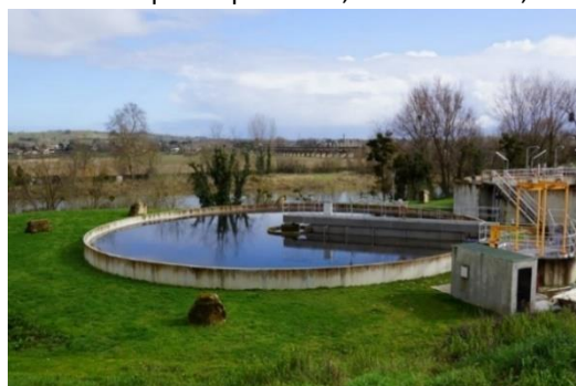
Image n°9 : Exemple d'une station d'épuration
