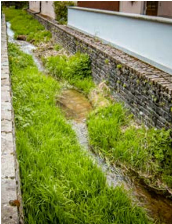
Aufwertung der Gewässersohle des Burbichs in Arsdorf durch bewachsene Kiesbänke (links) und Störsteine (rechts). (Fotos: Planungsbüro Zumbroich, 2019)
