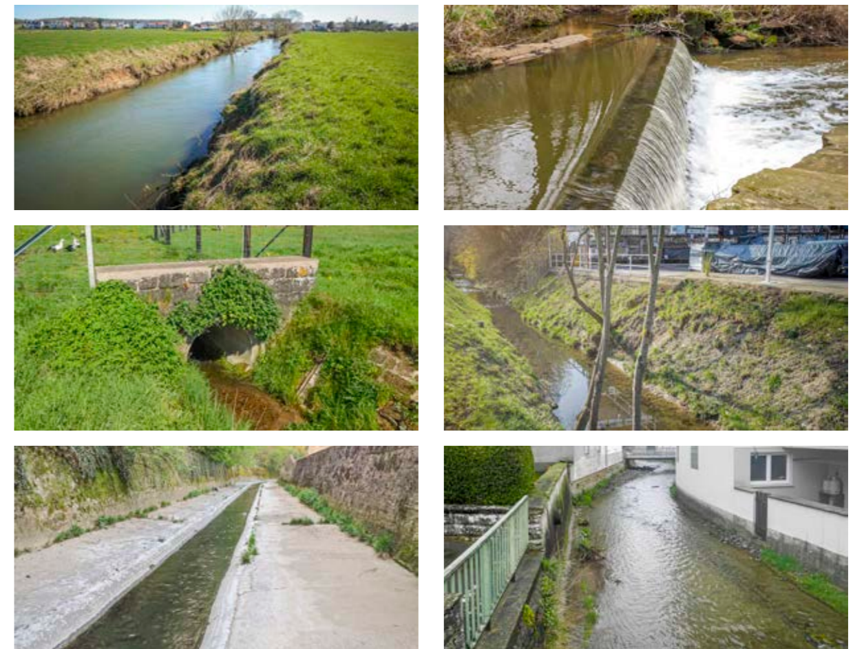
Zahlreiche morphologische, d.h. strukturelle Belastungen beeinträchtigen die Fließgewässer: fehlende Gewässerrandstreifen (oben links), Querbauwerke (oben rechts), Verrohrungen (Mitte links), Eintiefungen (Mitte rechts), Verbau von Sohle und Ufer (unten links) sowie Bebauung bis an den Gewässerrand (unten rechts). (Fotos: Planungsbüro Zumbroich, 2020)
