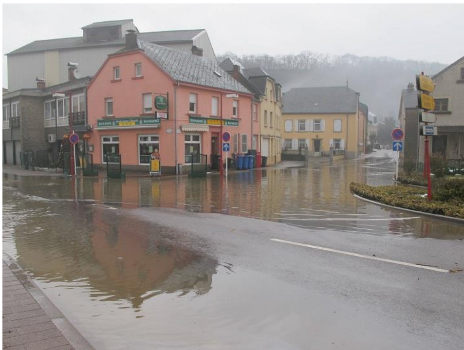
Abbildung 21: Hochwasser in Reisdorf (Sauer) am 07.01.2011
