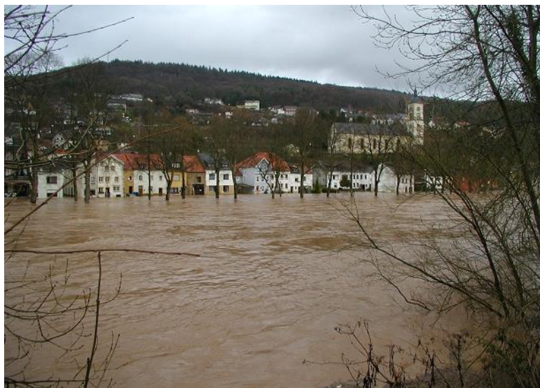
Abbildung 17: Hochwasser Januar 2003 in Bollendorf (Sauer)
