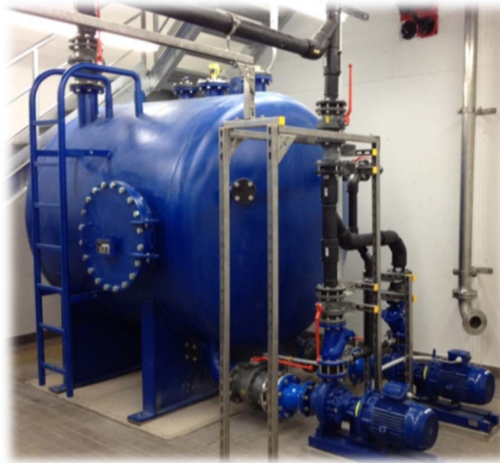
Installation der Unterdrucktanks in der Vakuumstation auf dem Betriebshof und Inbetriebnahme Ende 2016
