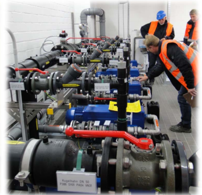
Installation der Unterdrucktanks in der Vakuumstation auf dem Betriebshof und Inbetriebnahme Ende 2016
