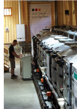
2018: Grauwasserrecycling und Wärmerückgewinnung in Frankfurt/Main für 28 und 66 Wohneinheiten der FAAG
