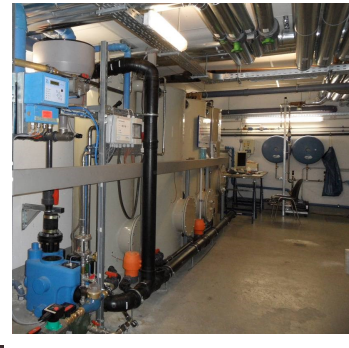
2011: Grauwasserrecycling und Wärmerückgewinnung in Berlin für 40 Wohn- und 6 Gewerbeeinheiten
