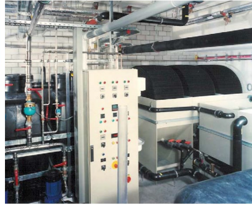
2011: Grauwasserrecycling und Wärmerückgewinnung in Berlin für 40 Wohn- und 6 Gewerbeeinheiten
