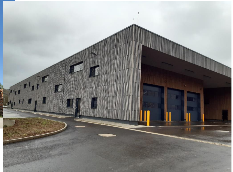
Dépôt des Ponts et Chaussées in Echternach
