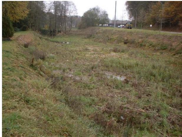
Abbildung 64: Hochwasserbypass an der Attert in Bissen
