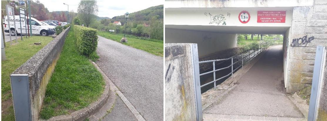
Abbildung 60: Hochwasserschutzmauer in Echternach (AGE)
