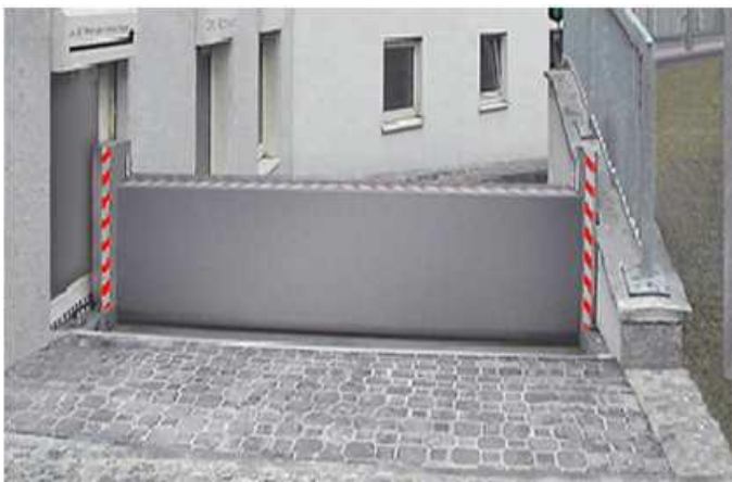
Abbildung 24: Sich selbst aufstellendes Klappschild als Objektschutzsystem. Quelle: Jomos AG
