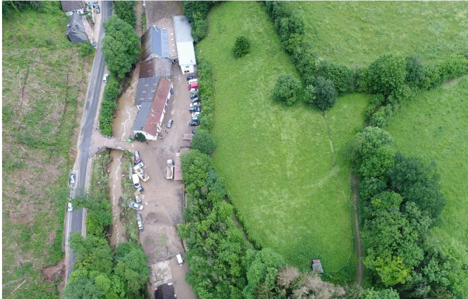
Abbildung 42: Schäden in Grundhof
