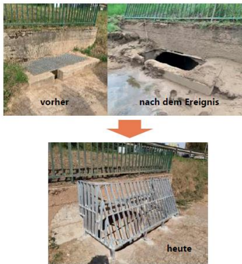
Abbildung 15: Einlaufbauwerk in Seltz, 2020. Service Regional Nord – EEPI, 2020
