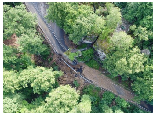
Abbildung 40: Entstehungsgebiet eines verstärkten Abflusses, Abschwemmungen von Boden, Tiefenerosion, Abrutschung der Straße
