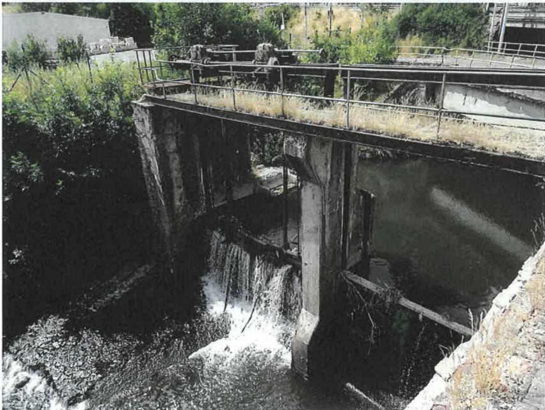
Vue latérale de l'ouvrage (de la rive gauche)
