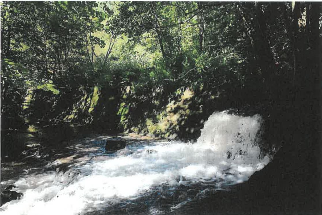
Vue de l'aval du barrage
