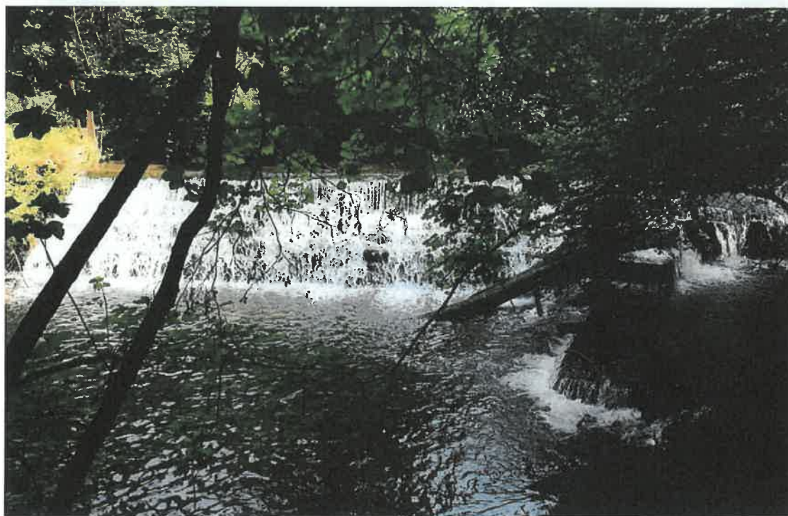
Vue de l'aval du barrage
