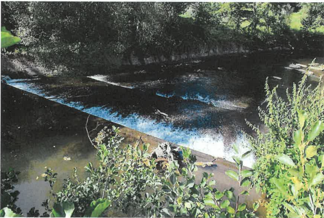
Vue de l'amont du barrage
