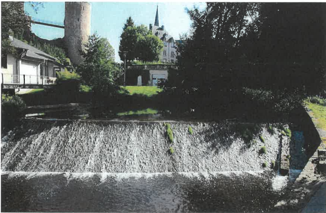
Vue de l'aval du barrage
