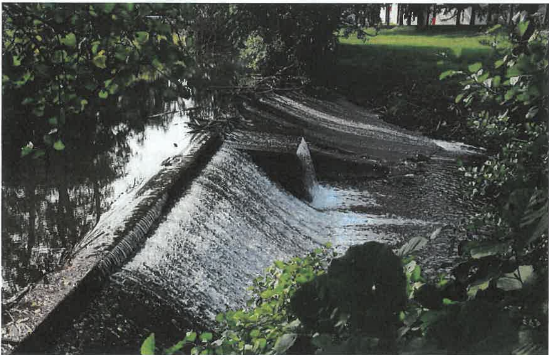
Vue latérale de rive droite
