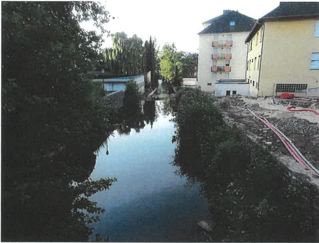
La rive en amont du barrage
