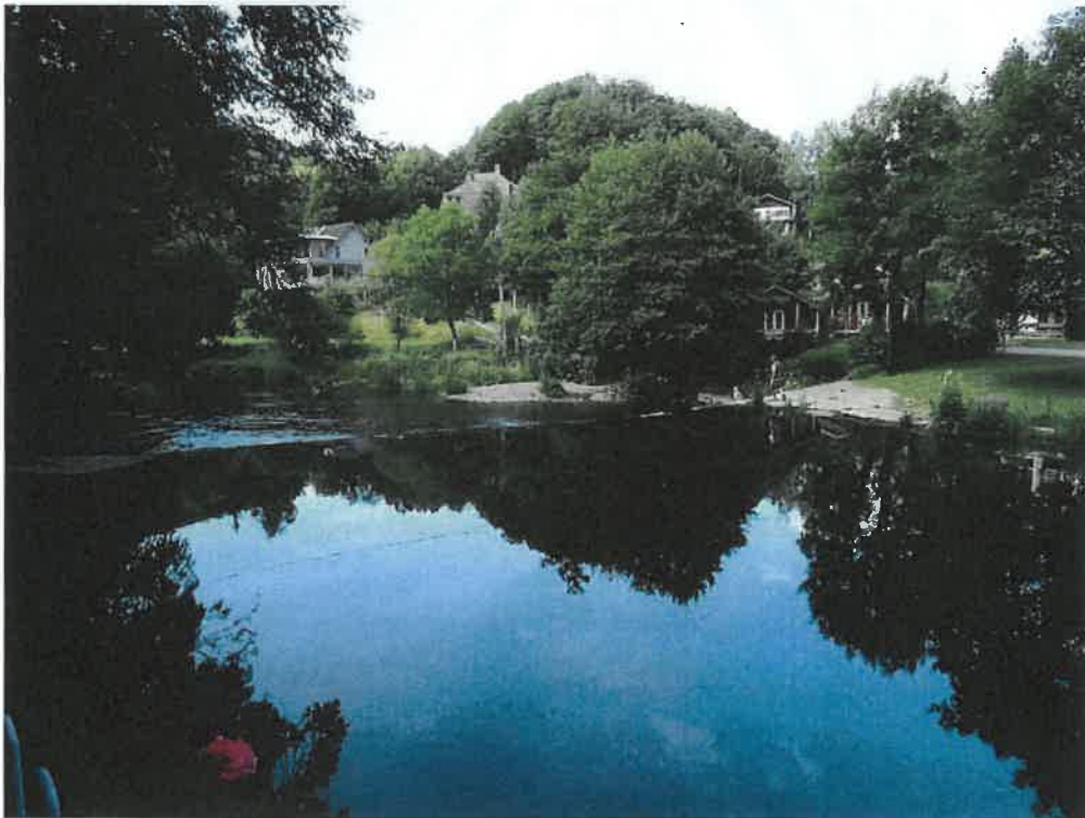
Vue de l'amont du barrage
