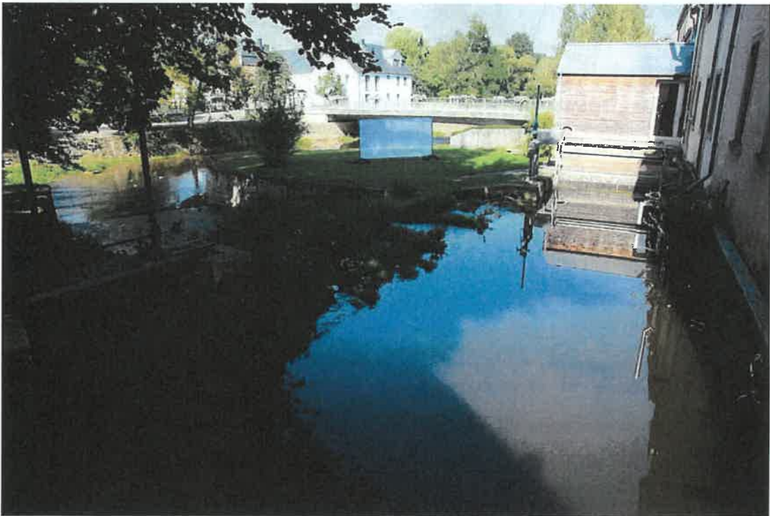
Déservoir de trop plein existant et grille de protection
