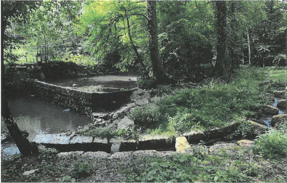
Vue latérale du barrage et échelle à poissons de la rive gauche
