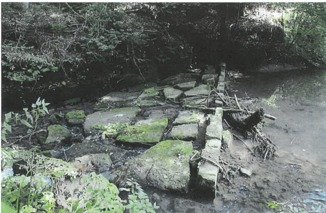
Vue latérale de l'ouvrage (de rive droite)
