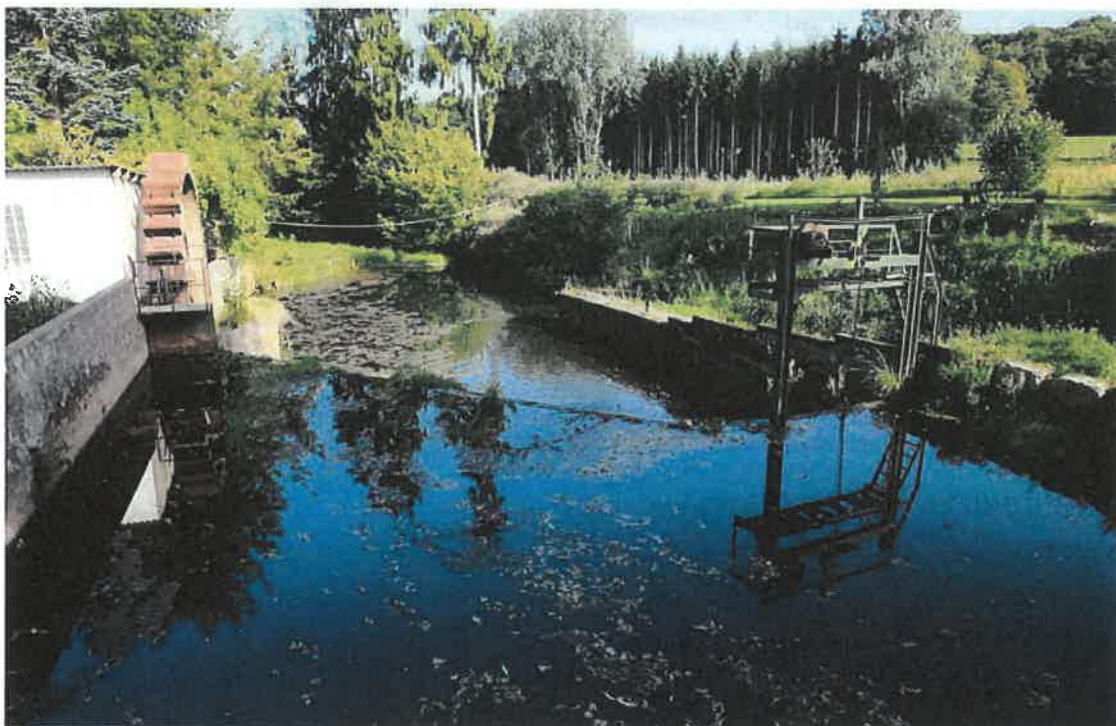
Vue de l'amont du barrage
