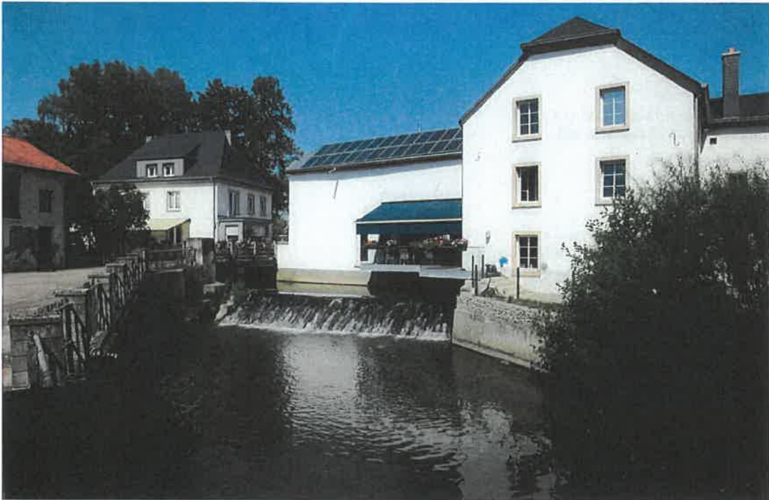
Vue de l'aval vers le barrage et les bâtiments adjacents
