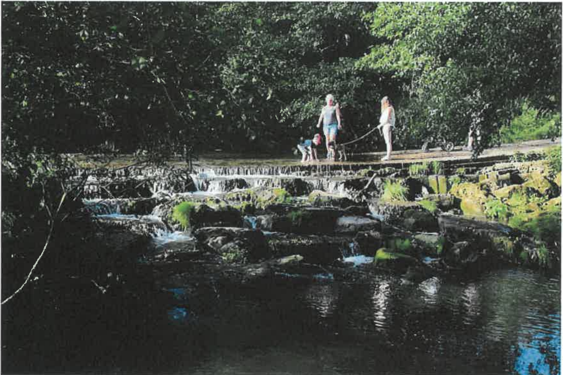
Vue de l'appareil en blocs rocheux existants (vu de l'aval du barrage)
