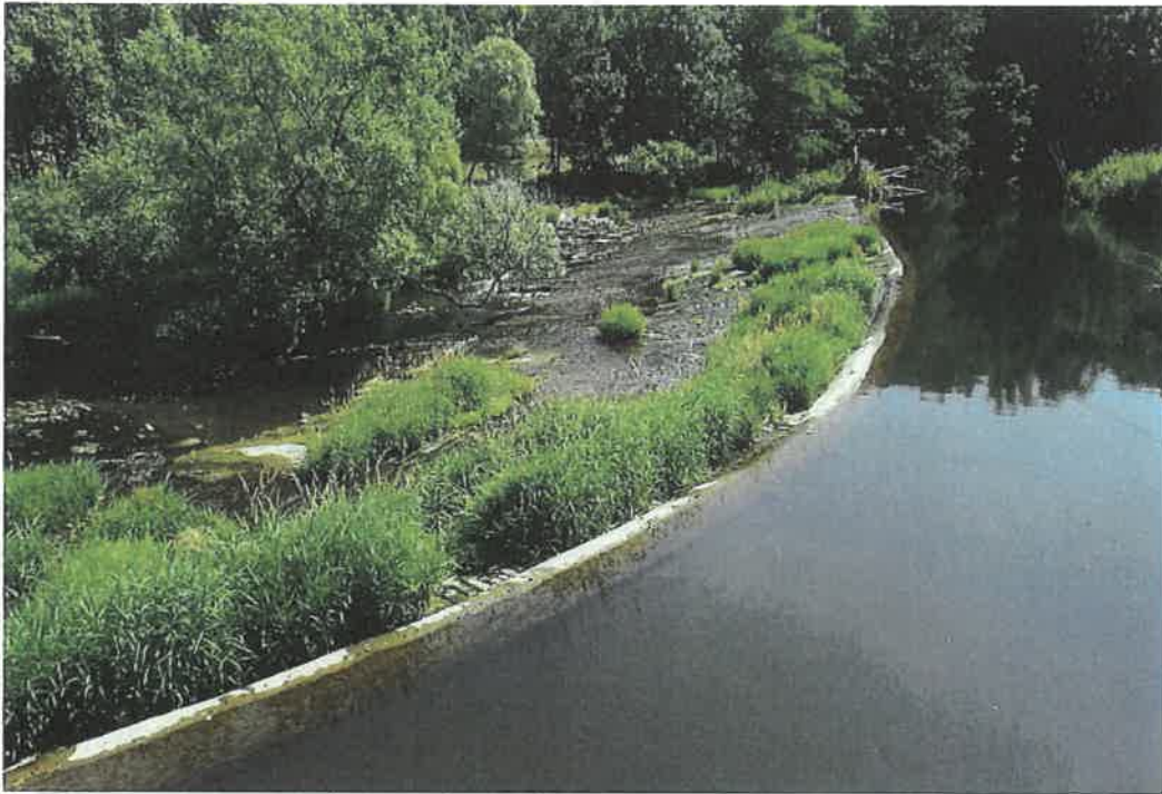
Vue latérale du barrage (vue de rive gauche vers le chenal du moulin)
