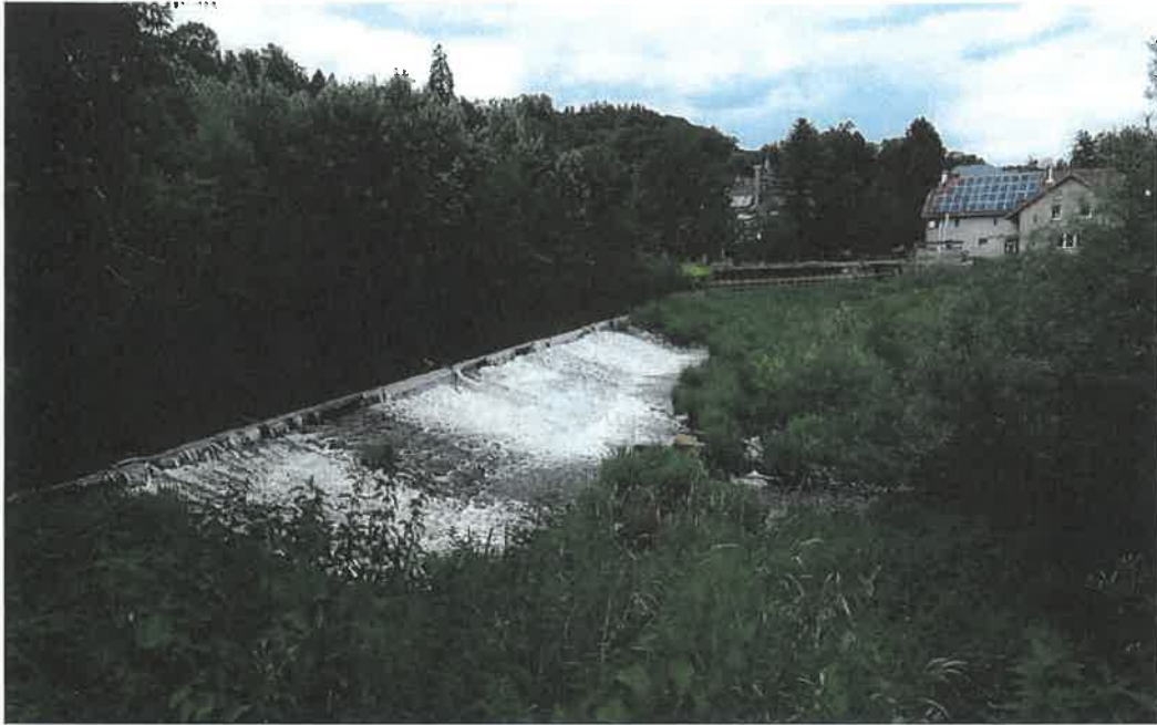
Vue latérale du barrage (de la rive droite)
