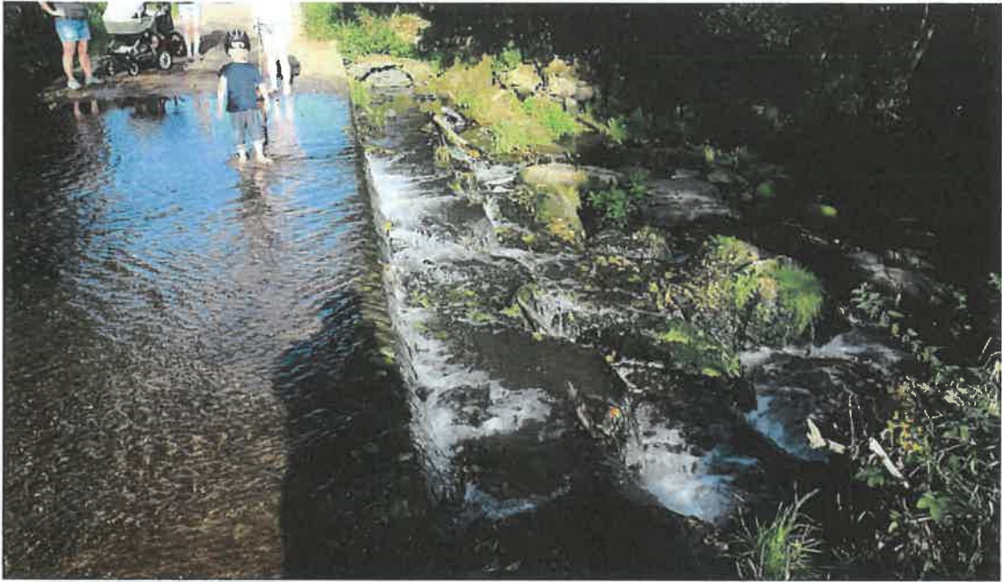
Vue de la traversée de l'Attert et du seuil existant
