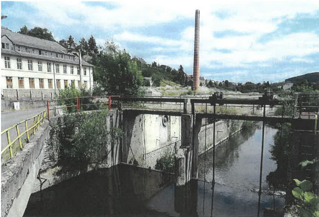
L'ouvrage vu de l'amont
