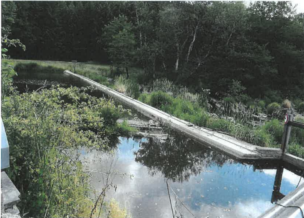
Vue de l'ouvrage de l'amont
