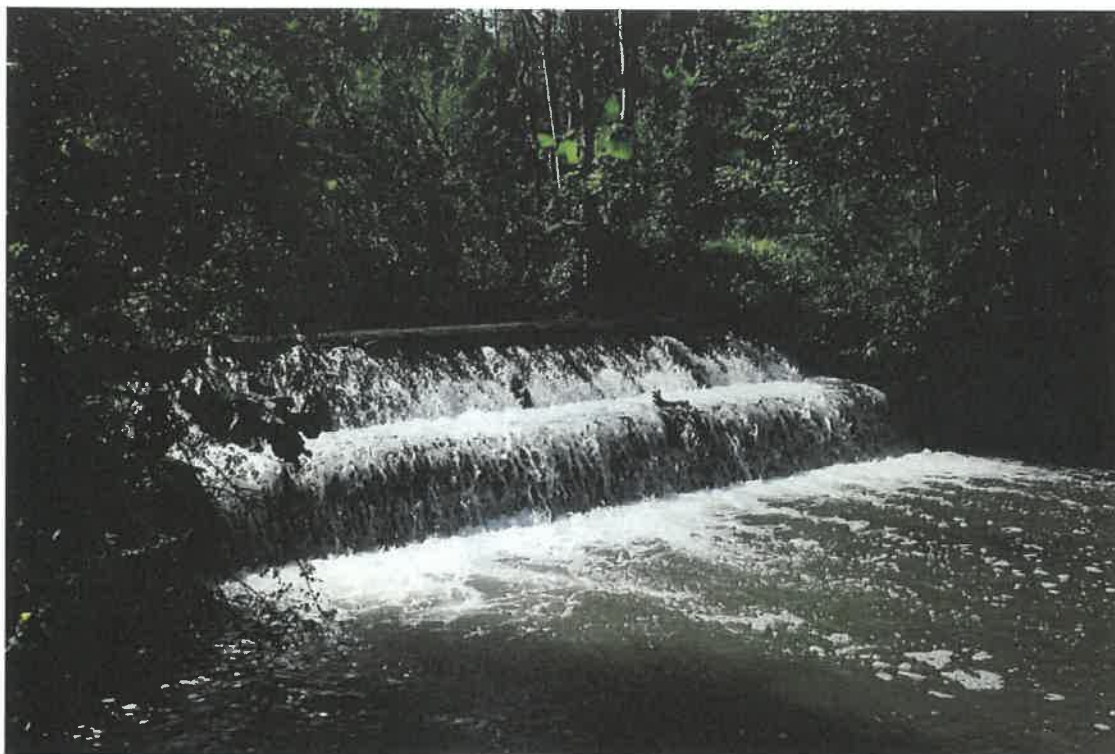
Vue du barrage de l'aval
