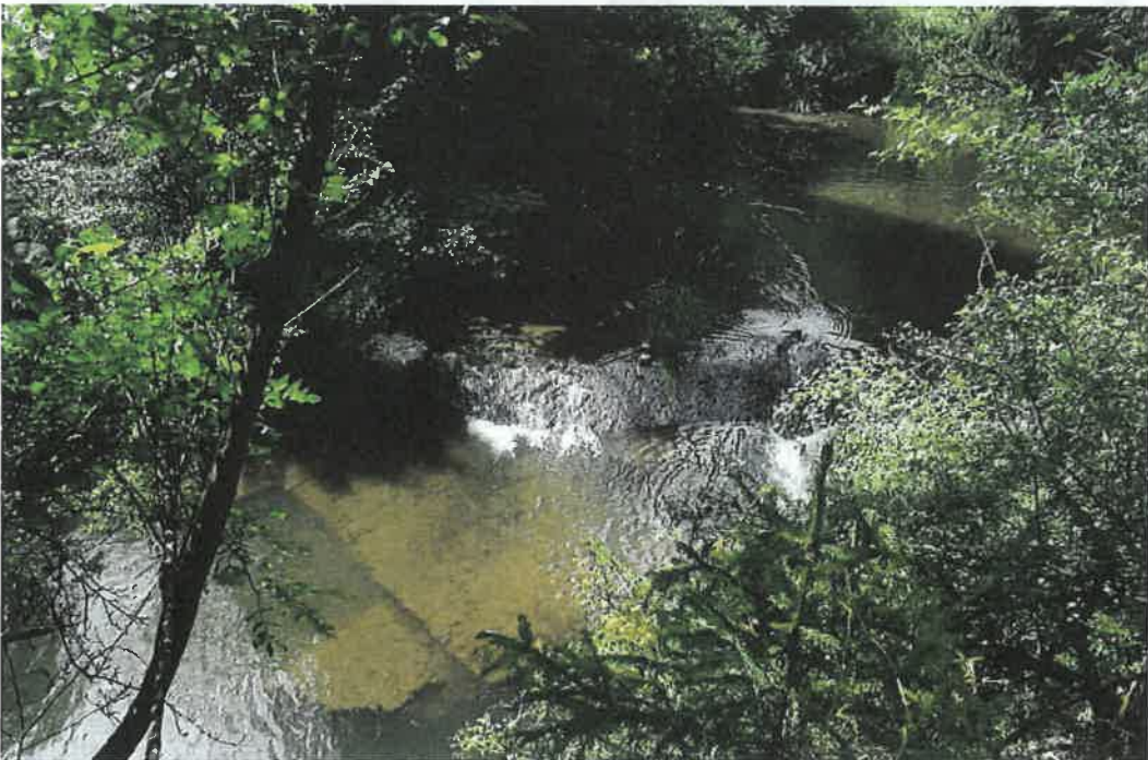
Vue du barrage de l'aval
