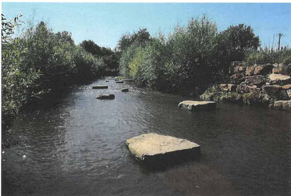
Vue de l'amont de la situation existante
