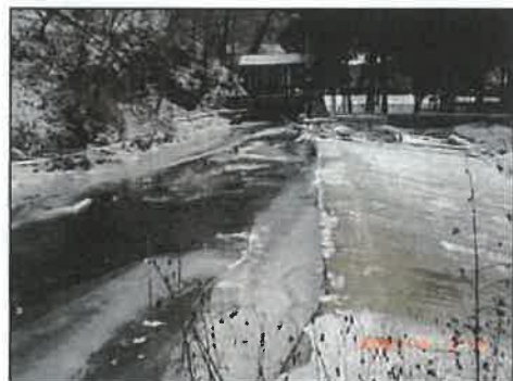
Vue de la crête et vers l'écluse et le chenal du moulin
