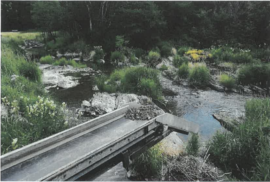
Vue de la rive de l'aval et l'échelle à poissons
