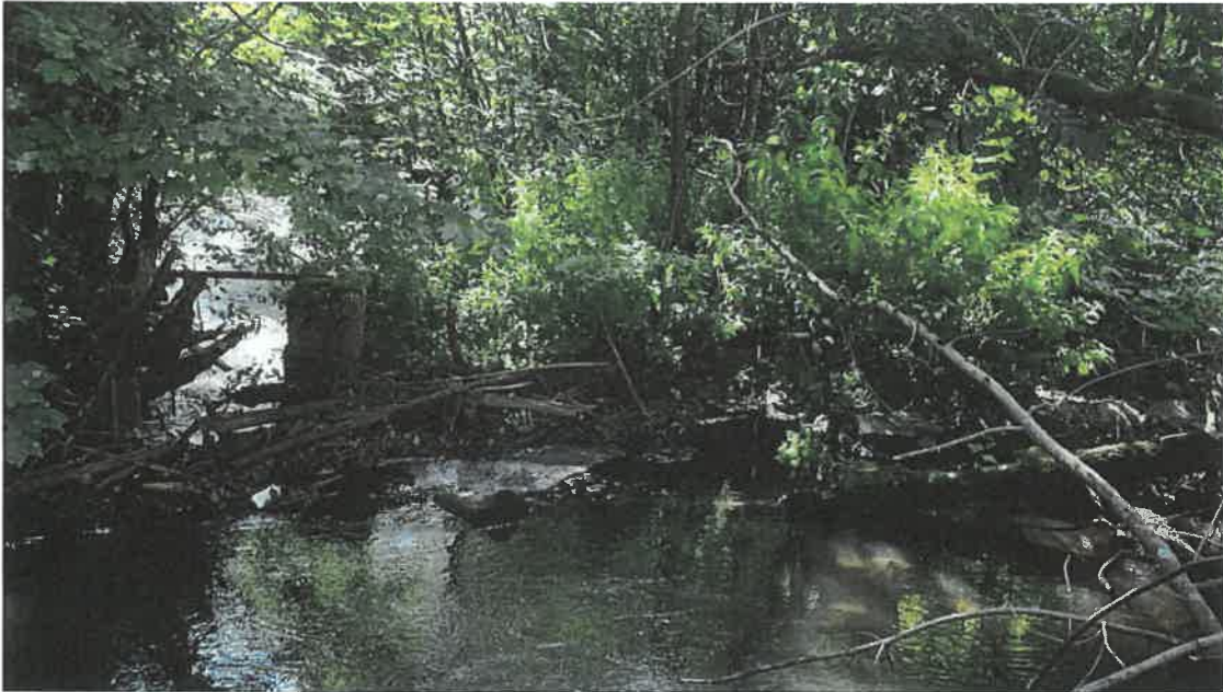
Vue de l'amont du barrage
