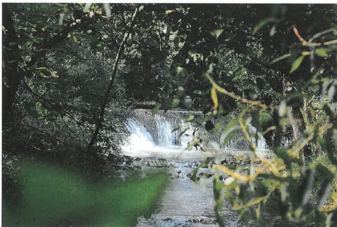
Le barrage vu de l'aval
