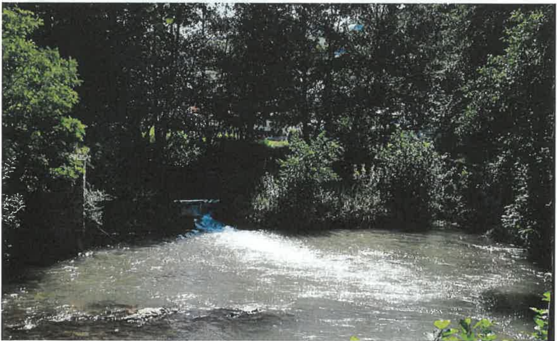
Vue du barrage de l'aval
