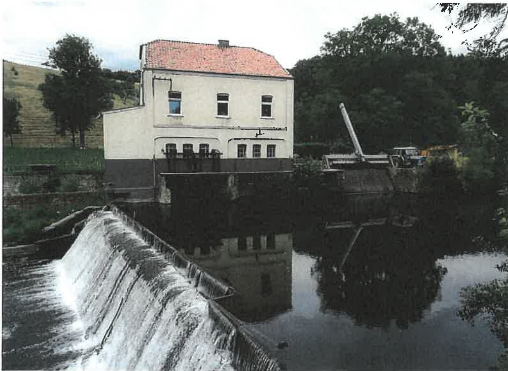
Vue latérale de l'ouvrage (rive gauche)
