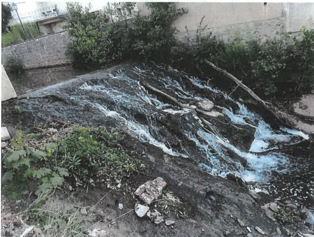
Vue latérale du barrage (de la rive droite)
