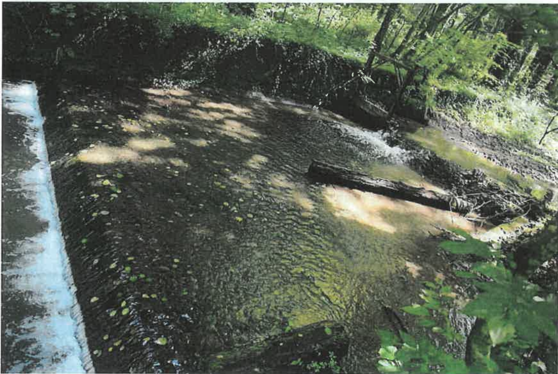
Vue de l'aval du seuil
