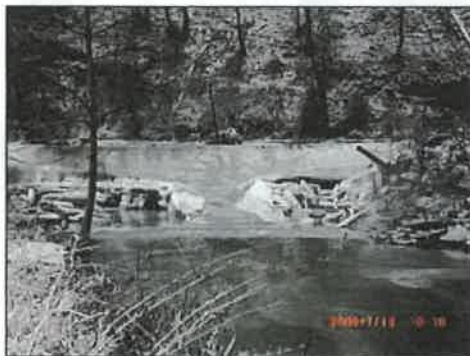
Vue du barrage (de l'aval)
