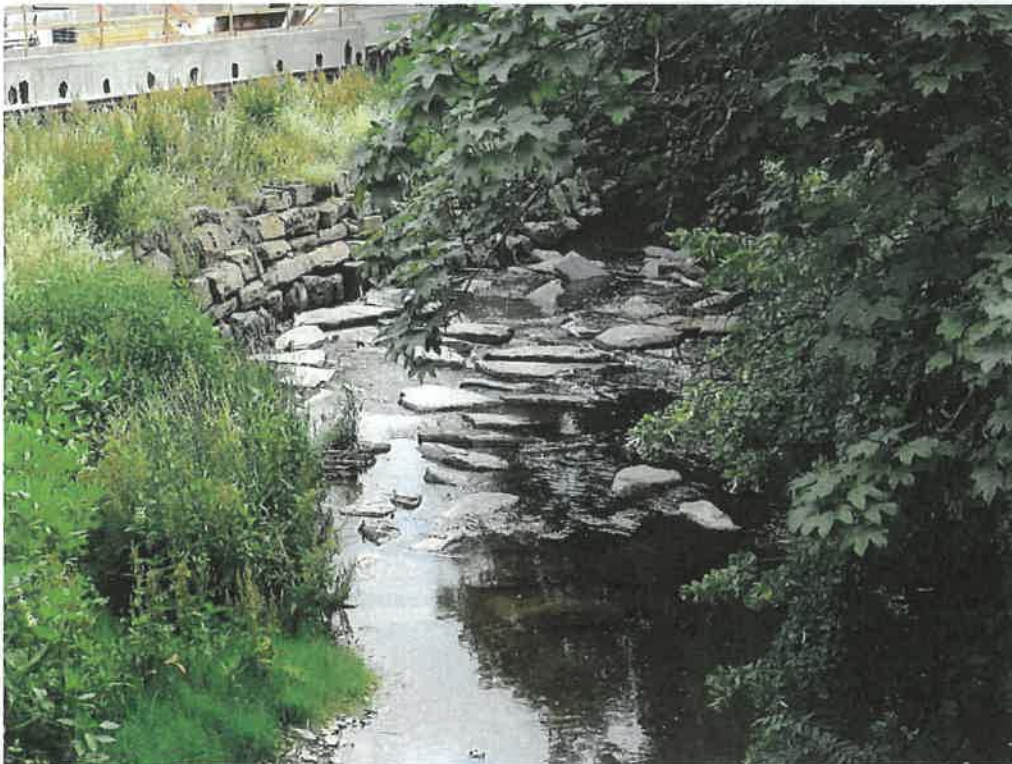
Vues de l'amont
