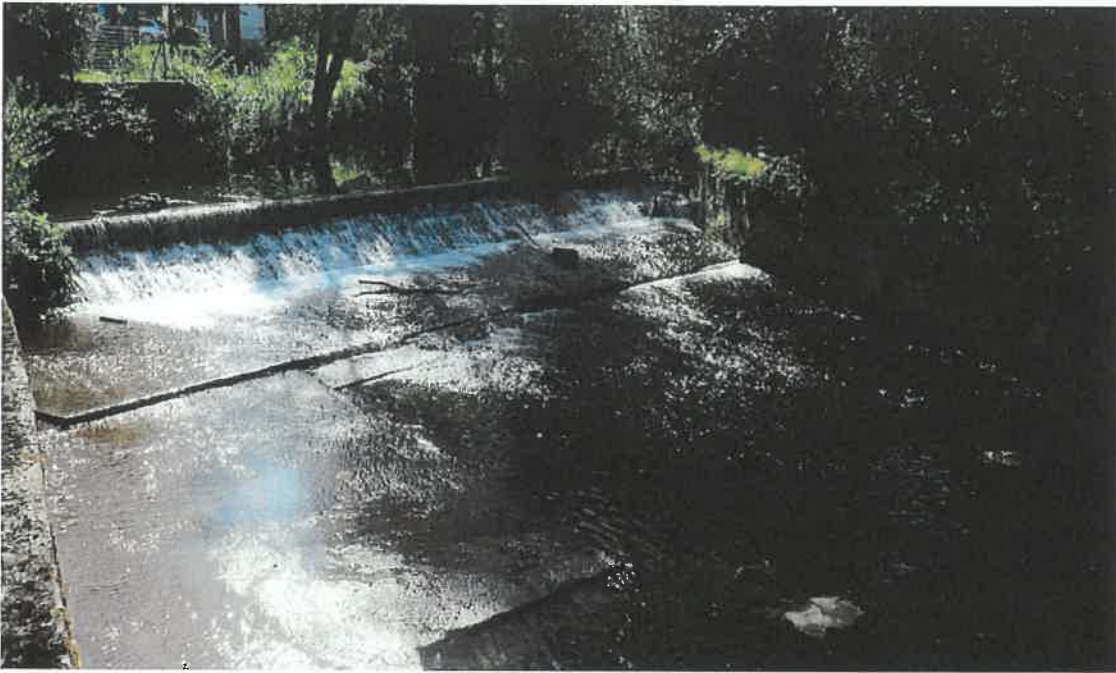
Vue latérale du barrage (rive droite)
