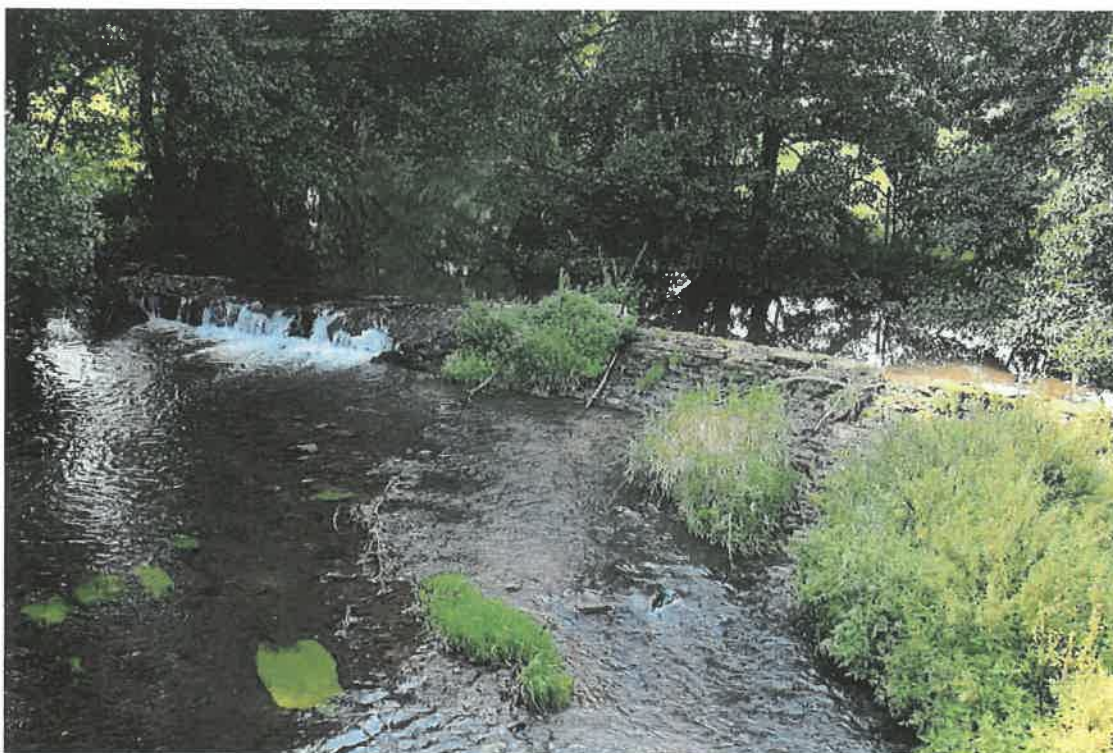
Le barrage vu de l'aval
