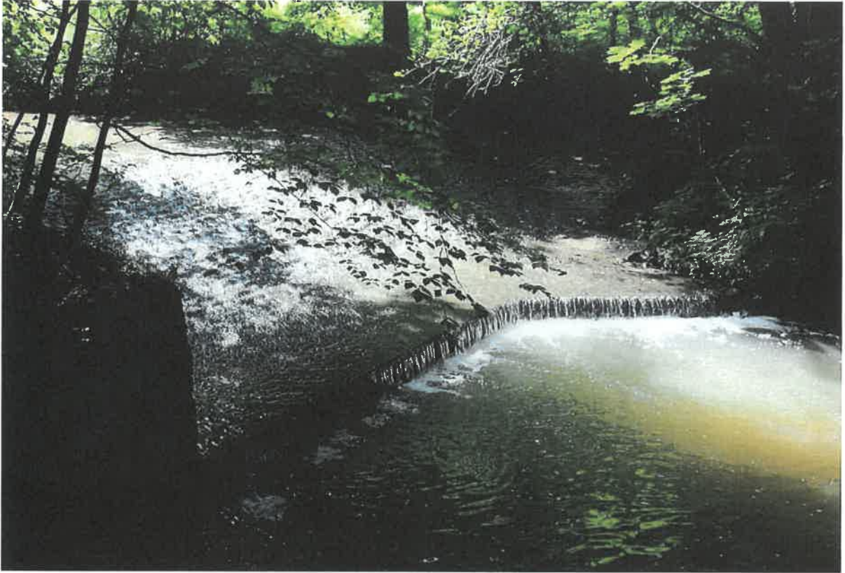
Vue sur l'ouvrage
