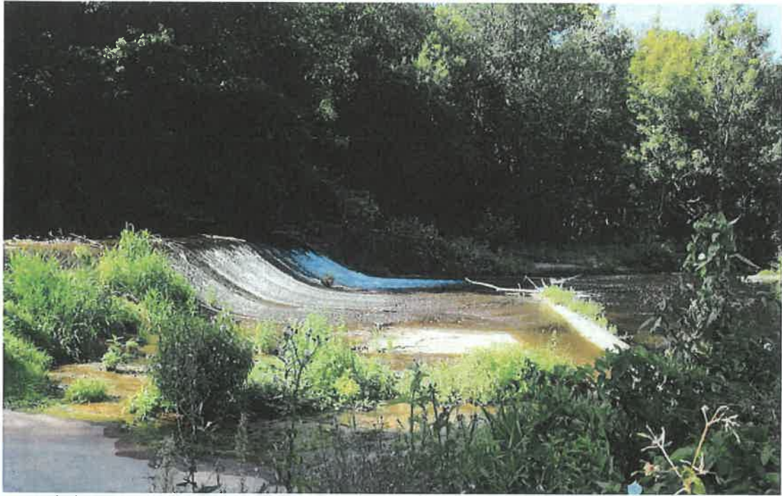
Vue latérale du barrage (de rive droite)
