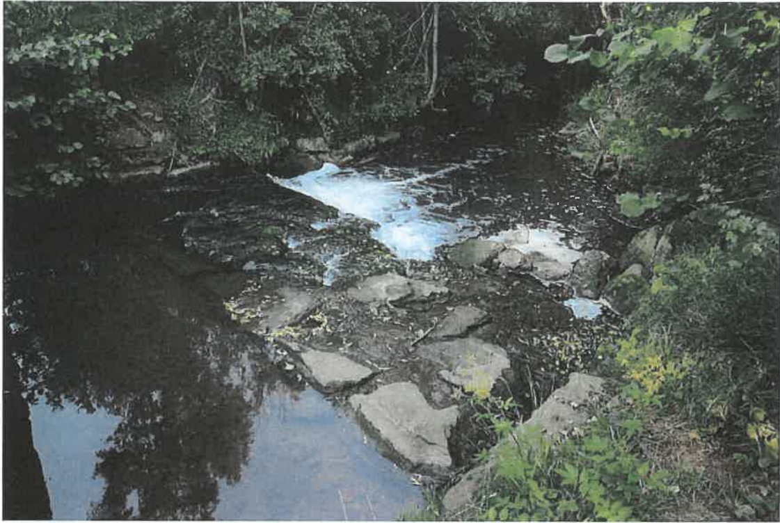
Vue sur l'ouvrage
