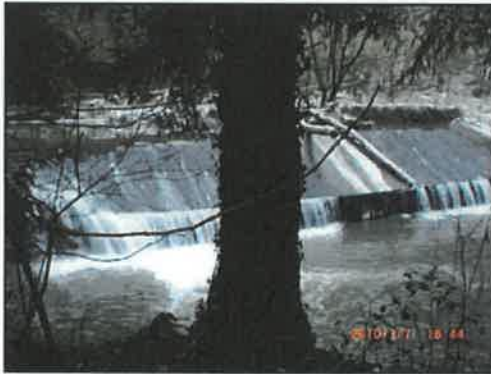
Vue du barrage de la rive droite et de l'aval
