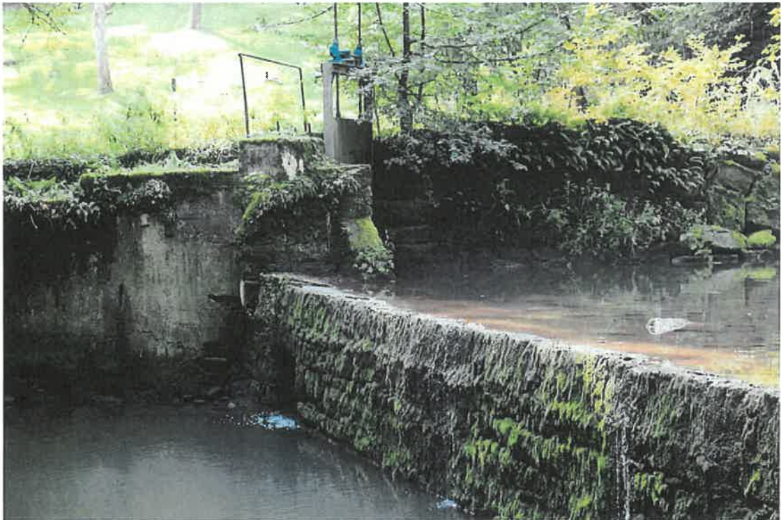
Détail du mur en pierres taillées et de la vanne de régulation
