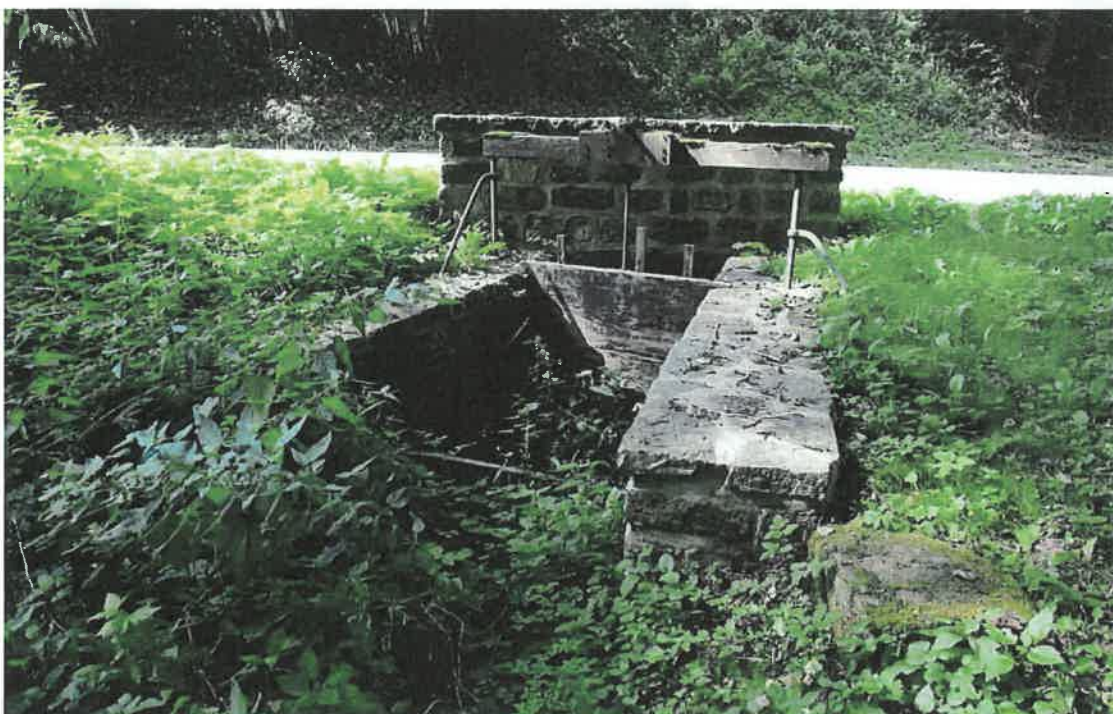
L'entrée vers le chenal du moulin
