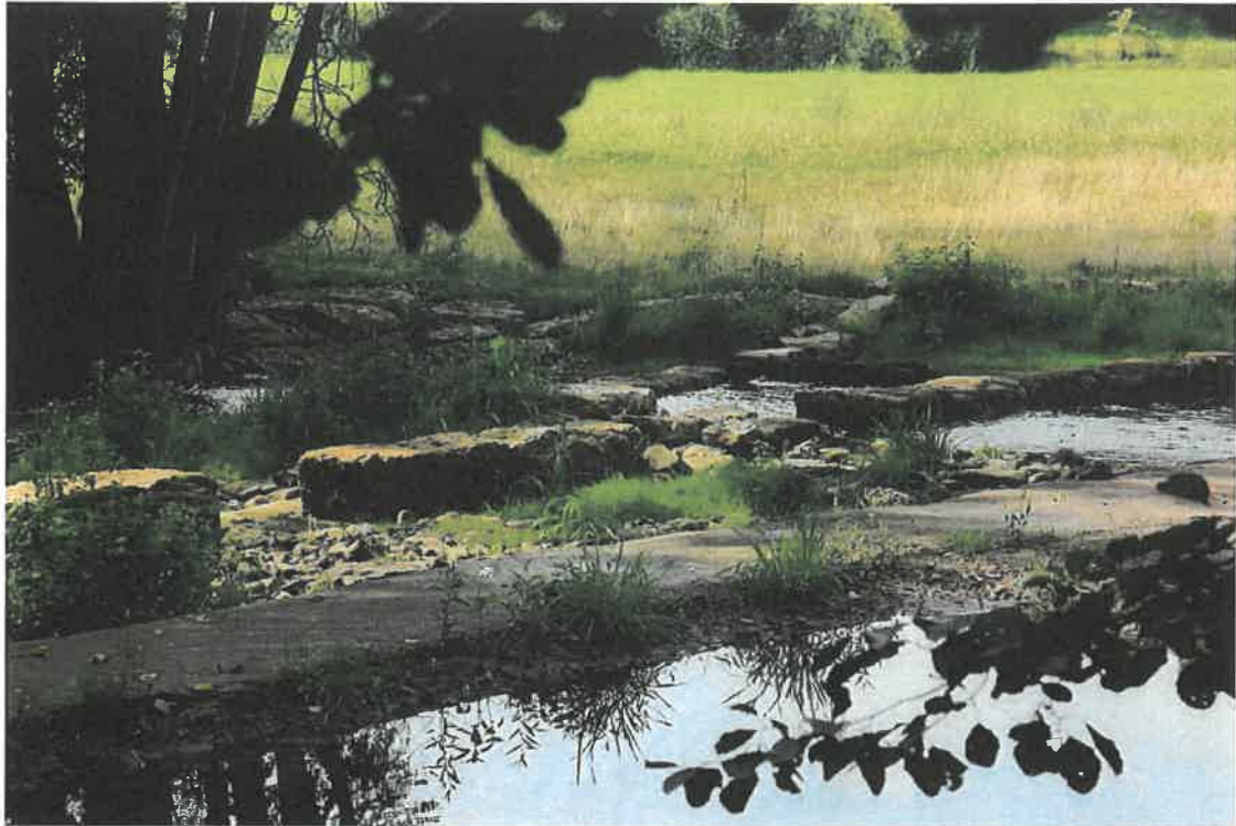
Vue sur l'ouvrage
