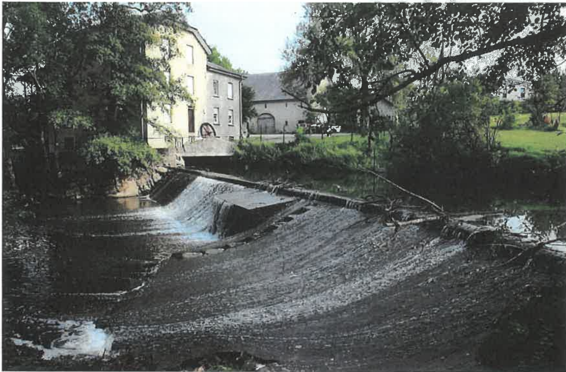
Crête du barrage (vue latérale de rive gauche)
