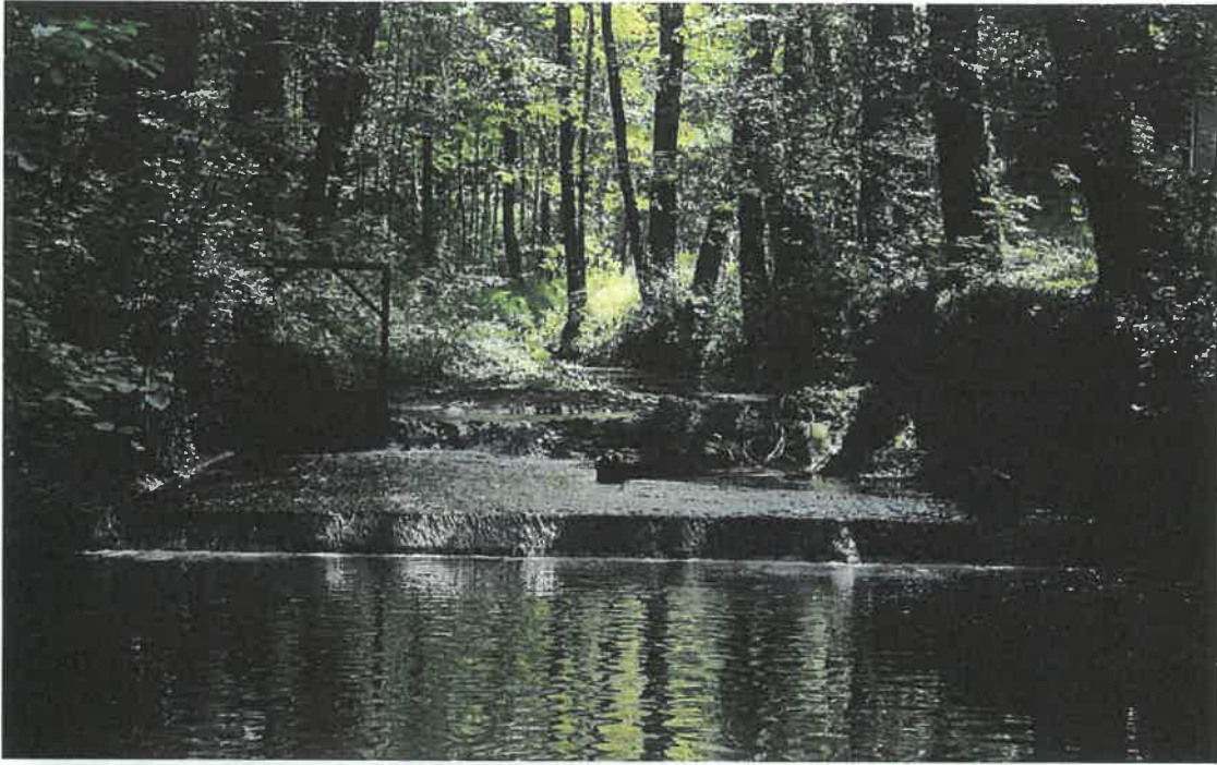
Vue de l'aval de l'ouvrage
