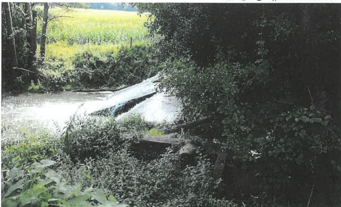
Crête du barrage (vue latérale de rive gauche)
