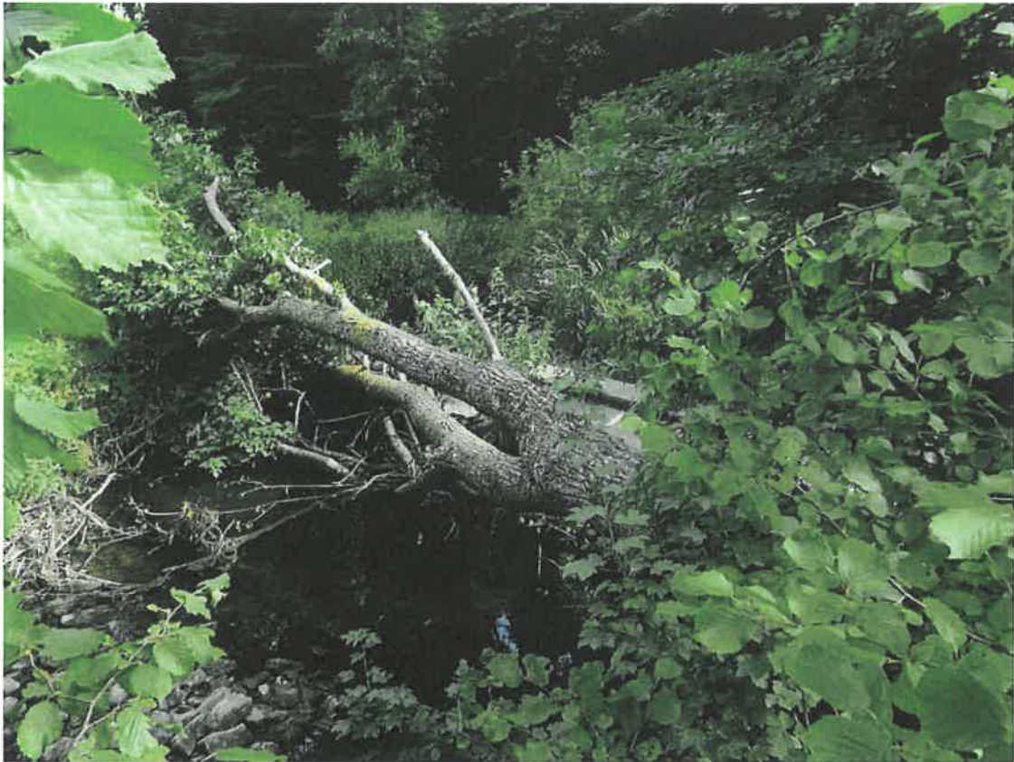
Vue du barrage de la rive gauche
