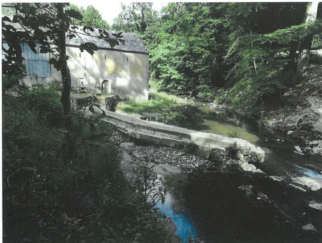
Vue de l'amont du barrage
