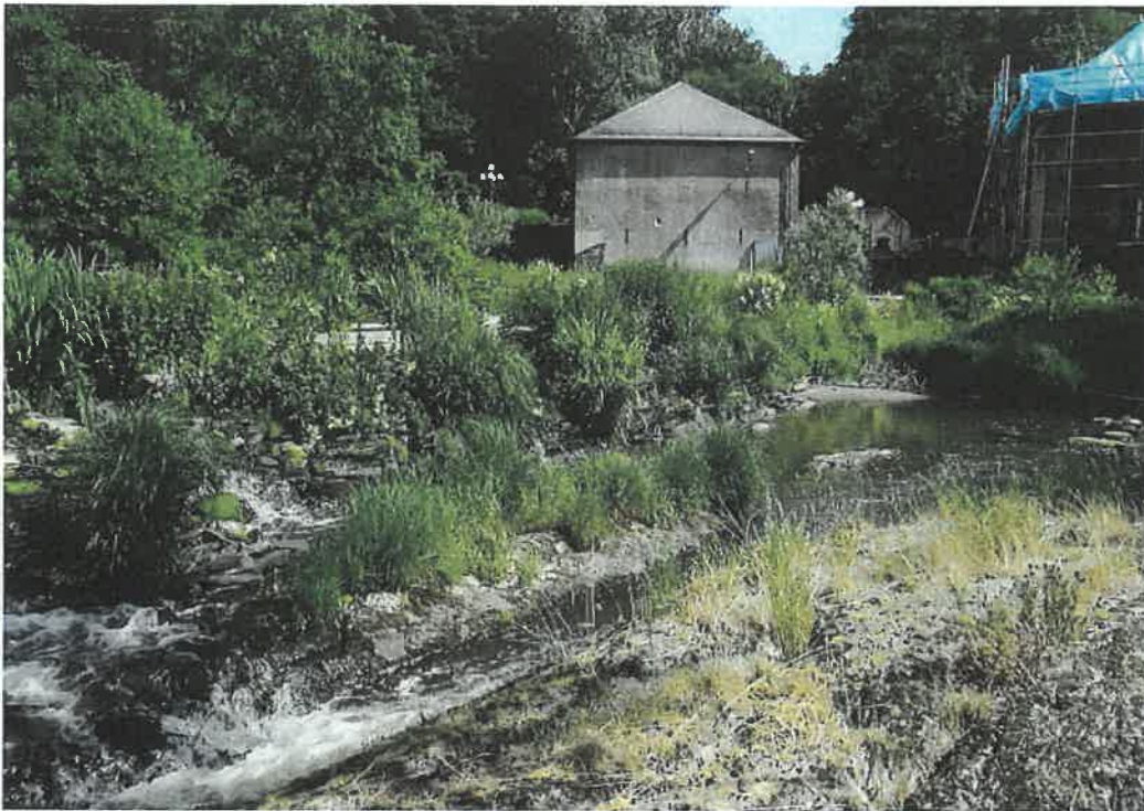
Vue latérale du barrage (rive droite)
