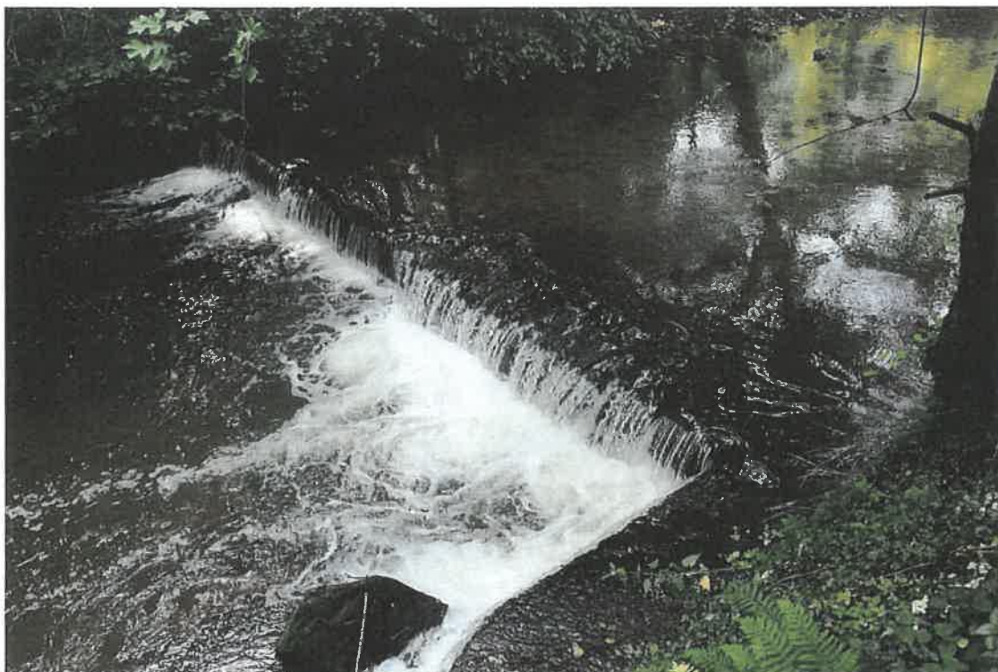
Vue sur les deux seuils consécutifs
