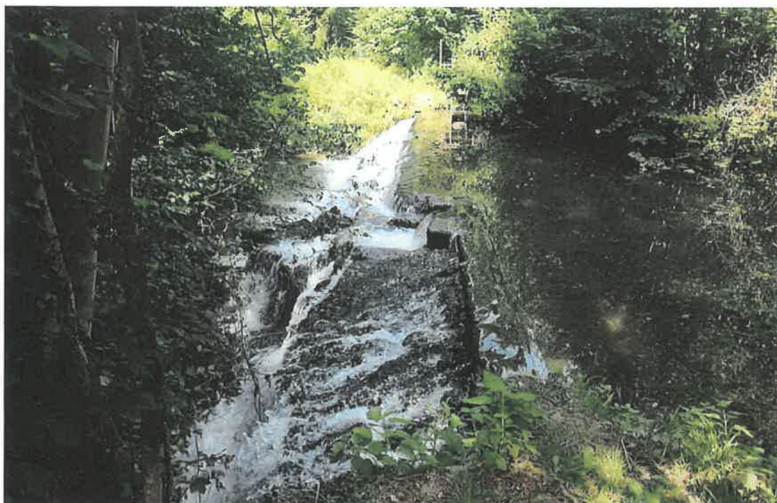
Vue latérale du barrage (de rive gauche)
