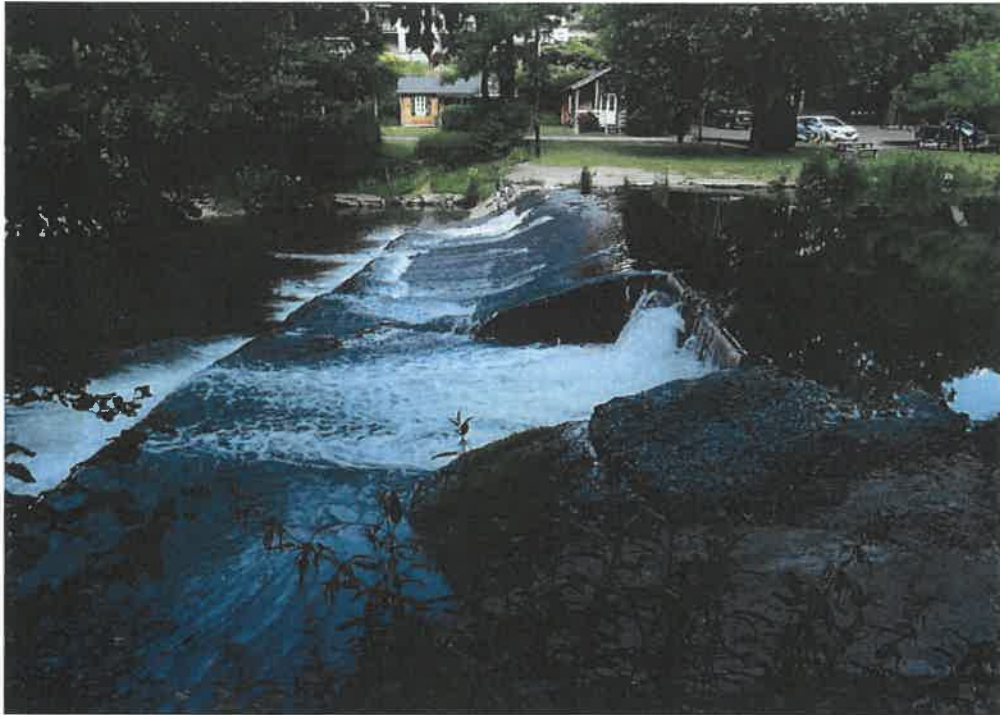
Vue latérale du barrage (de la rive gauche)
