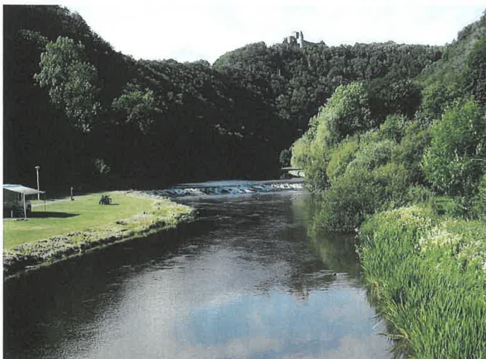
Vue du barrage de l'aval
