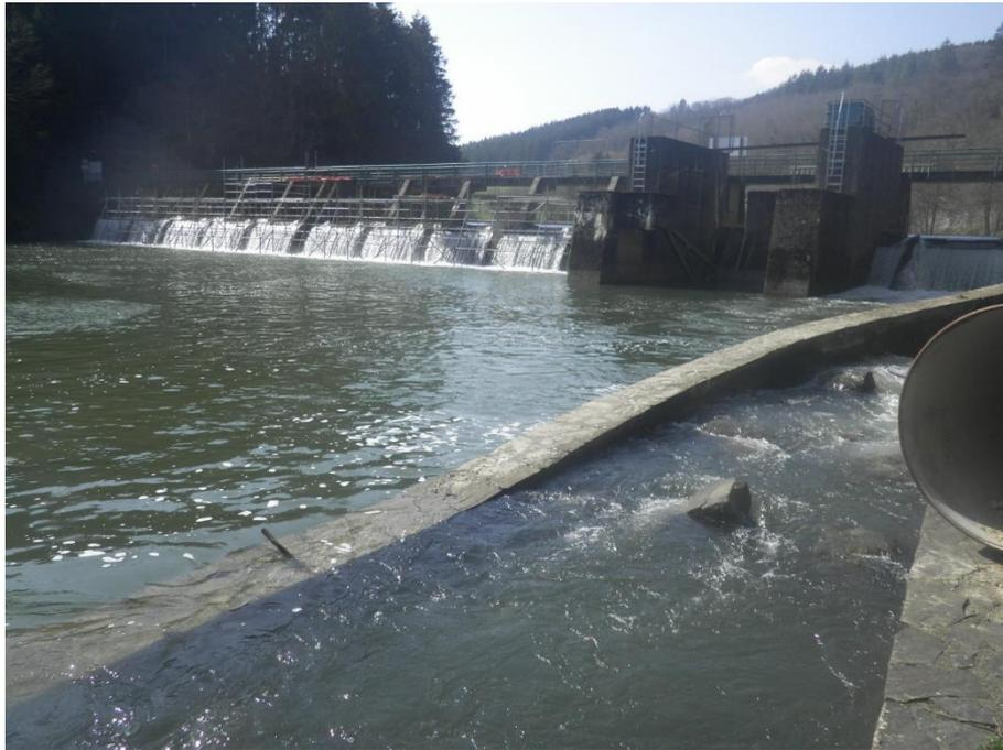
*Abbildung 8: Bewegliches Wehr zur Stauregulierung mit technischer Wanderhilfe, Querbauwerk-ID: 003\_1137\_QBW\_01*
