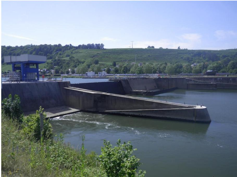
Abbildung 2: Schiffsschleuse in Grevenmacher und Wanderhilfe (Schlitzpass), Querbauwerk ID: 001\_0070\_QBW\_01<sup>3</sup>
