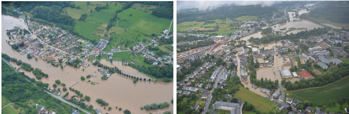
Abbildung 27: Überschwemmung in Steinheim (links) und Mersch (rechts) infolge des Hochwasser Juli 2021
