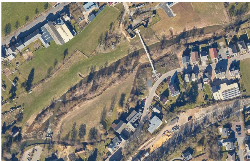
Abbildung 69: Übersicht über die Renaturierungsarbeiten an der Attert, oben: 2003, unter 2019 (Geopotail.lu)
