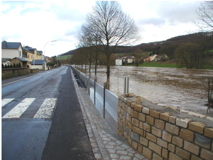
Abbildung 59: Hochwasserschutzmauer in Ingeldorf (AGE)
