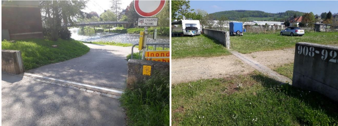
Abbildung 61: Hochwasserschutzmauer in Diekirch (AGE)
