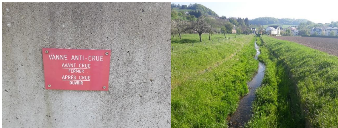
Abbildung 62: Hochwasserschutz in Diekirch: Schutz gegen Kanalarückstau (rechts) und Eindeichung des Tirelbaachs (links) (AGE)
