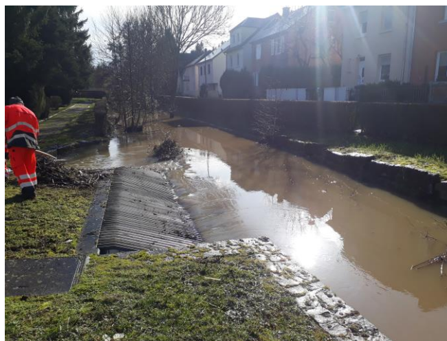
Abbildung 65: Umleitung des Osweilerbaches bei Hochwasser (AGE)
