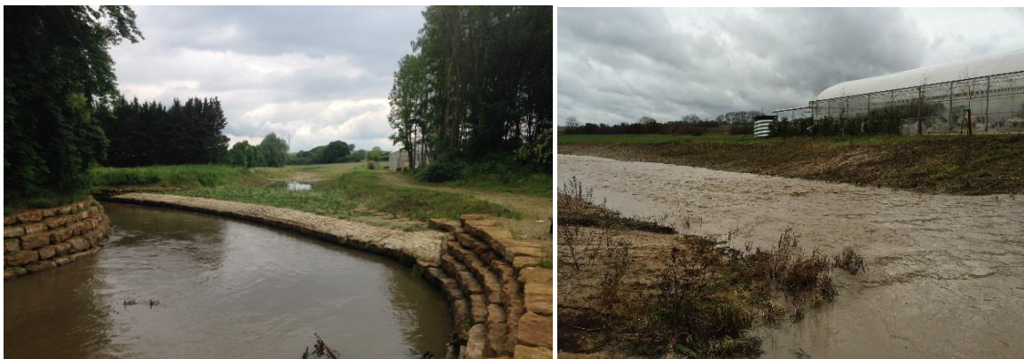
Abbildung 67: Hochwasserbypass der Gander in Mondorf-les-Bains
