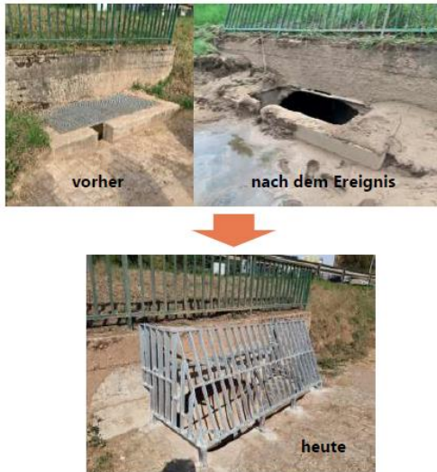
Abbildung 16: Einlaufbauwerk in Seltz, 2020. Service Regional Nord – EEPI, 2020
