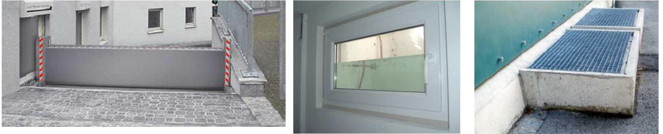
Abbildung 24: Beispiele von festen (aber beweglichen) Objektschutzmaßnahmen
