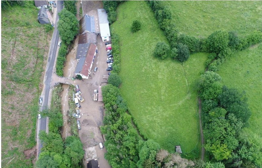
Abbildung 43: Schäden in Grundhof
