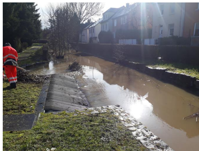
Abbildung 65: Umleitung des Osweilerbaches bei Hochwasser (AGE)
