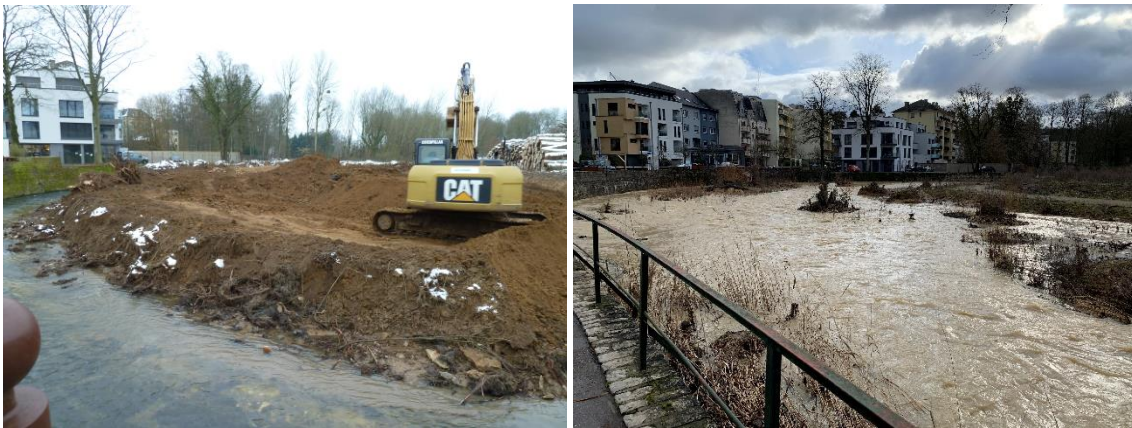
Abbildung 66: Gander in Mondorf-les-Bains, während der Arbeiten und nach Fertigstellung bei Hochwasser
