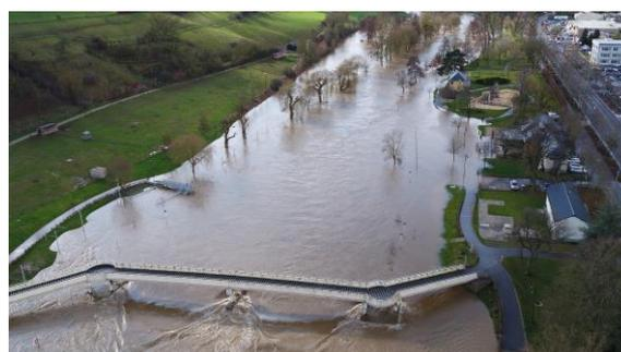
Abbildung 63: Schlauchwehr in Diekirch bei Hochwasser (AGE)
