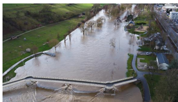
Abbildung 63: Schlauchwehr in Diekirch bei Hochwasser (AGE)
