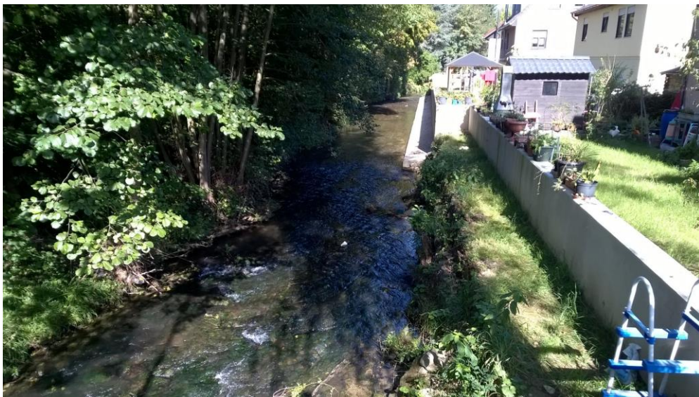
Abbildung 73: Hochwasserschutzmauer in Larochette (AGE)
