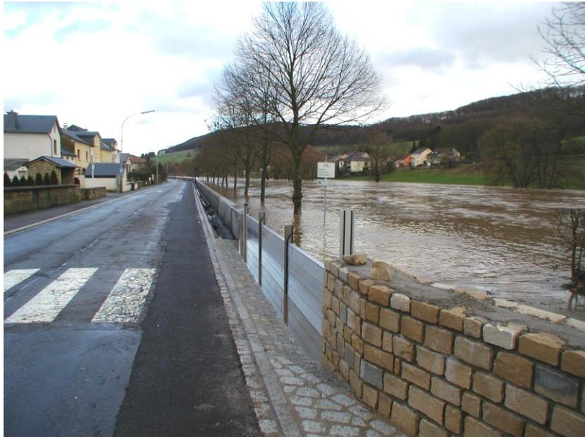
Abbildung 59: Hochwasserschutzmauer in Ingeldorf (AGE)
