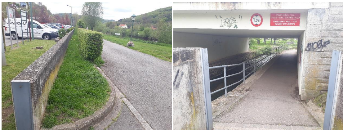
Abbildung 64: Hochwasserschutzmauer in Echternach (AGE)
