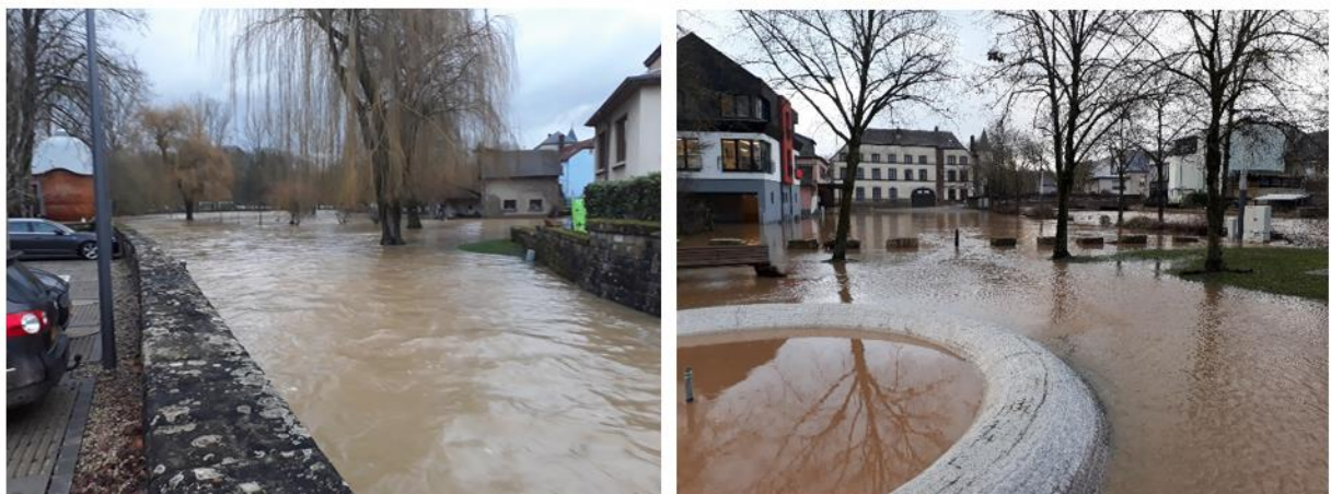
Abbildung 21: Hochwasser in Useldange und Bissen (AGE, 2020)
