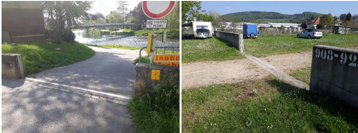
Abbildung 61: Hochwasserschutzmauer in Diekirch (AGE)
