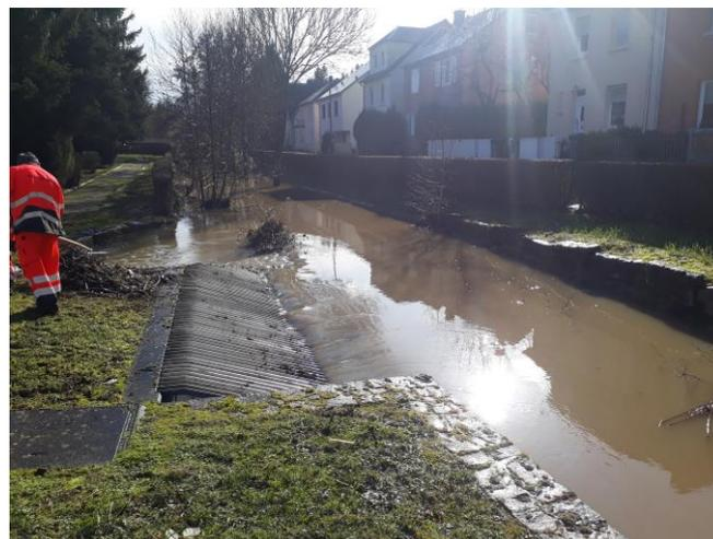
Abbildung 65: Umleitung des Osweilerbaches bei Hochwasser (AGE)
