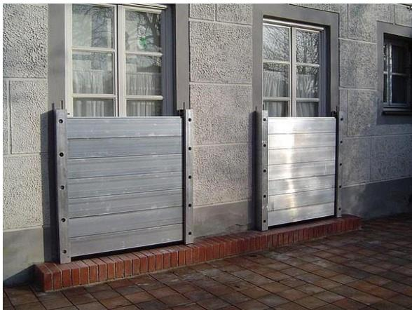
Abbildung 25: Mobiles Dammbalkenschutzsystem. Quelle: IBS GmbH
