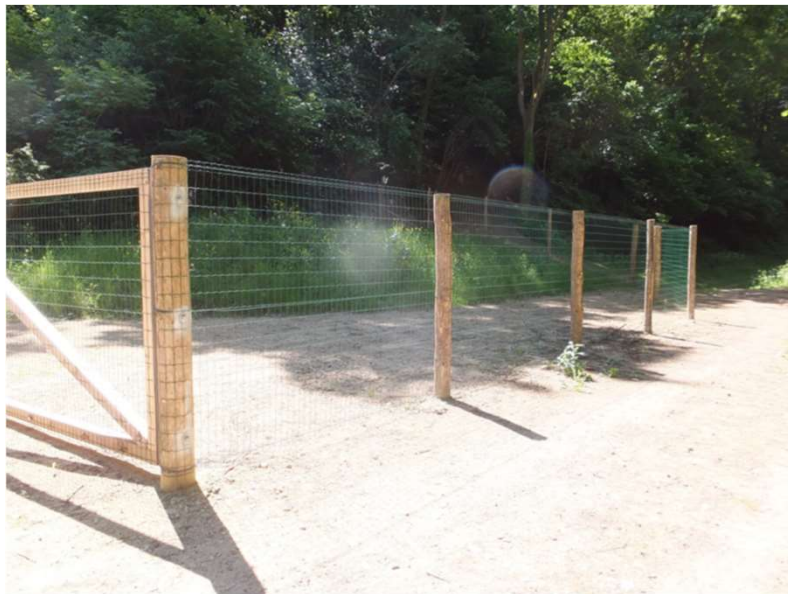
Clôture autour forage Soup I
