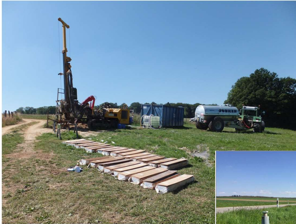
Travaux de forage pour la délimitation des ZPS des forages Soup
