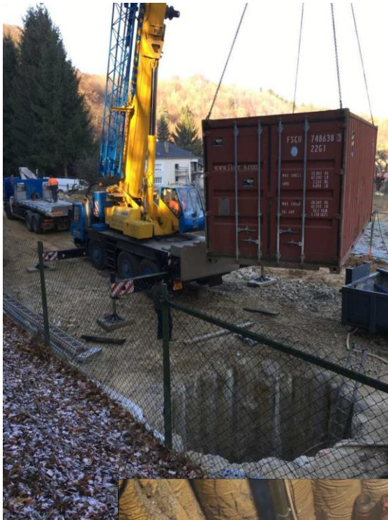
Travaux d'assainissement et de rénovation de la source Peiffer
