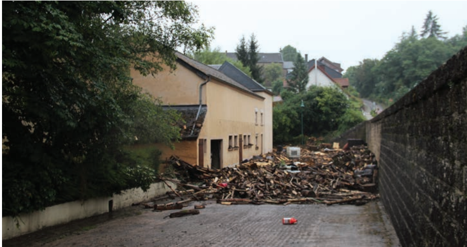
Abbildung 21 Angeschwemmtes Material infolge von Starkregen, 2016
