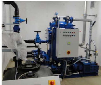
Stoffstromtrennung am Demonstrations- und Lernobjekt auf Gut Karlshöhe
