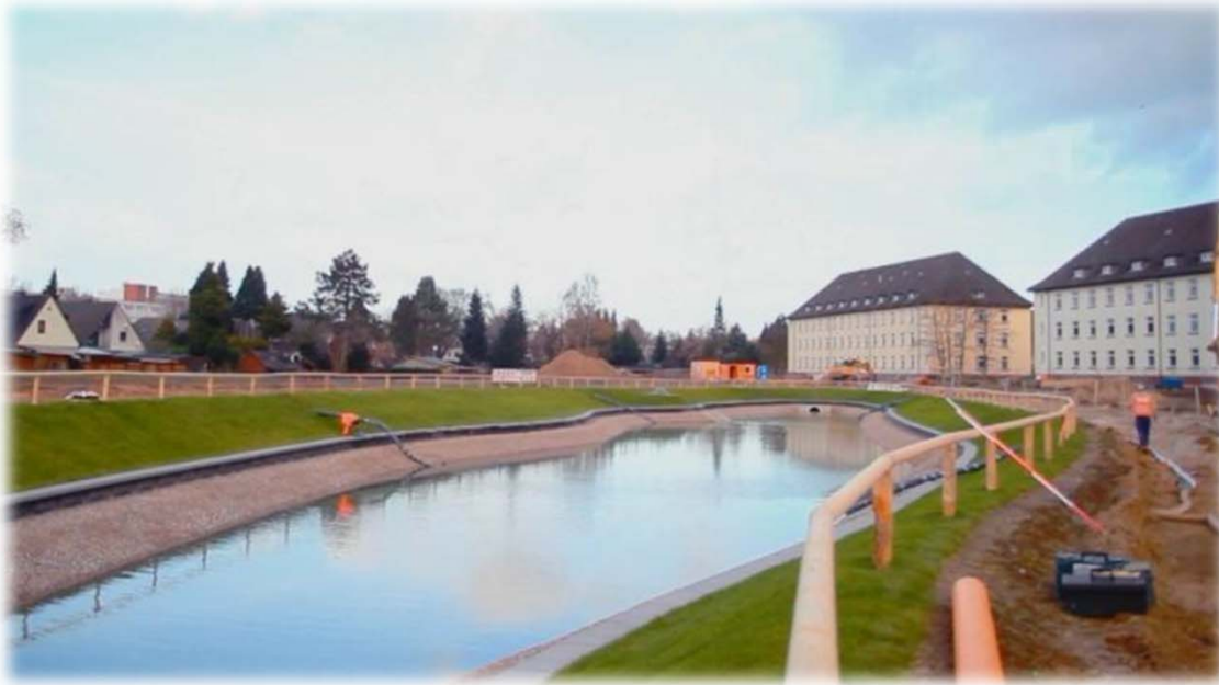
Fertigstellung des Kuehnbachteichs
