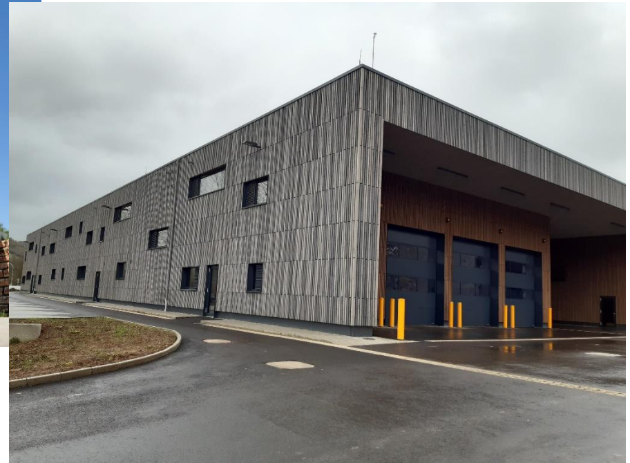
Dépôt des Ponts et Chaussées in Echternach
