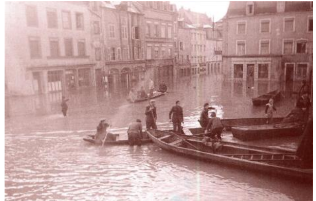
Abbildung 44: Hochwasserereignis Januar 1948 in Remich [54]
