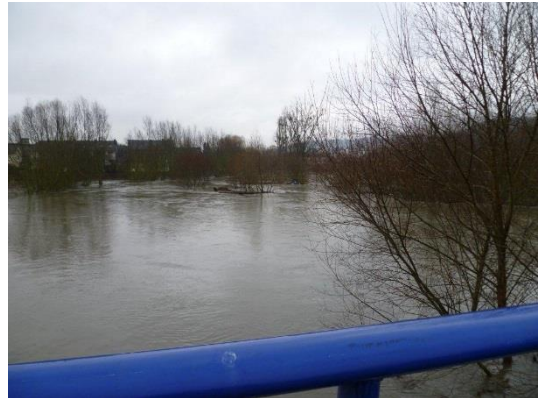
Abbildung 56: Hochwasser 2011 Brücke Bereldange-Walferdange
