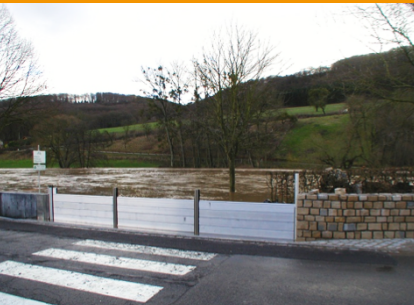
Ingeldorf, Crue en 2003
