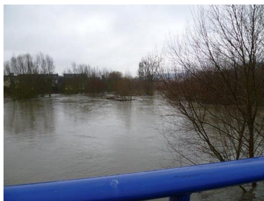
Illustration 56: Crue de 2011 - Pont Bereldange-Walferdange
