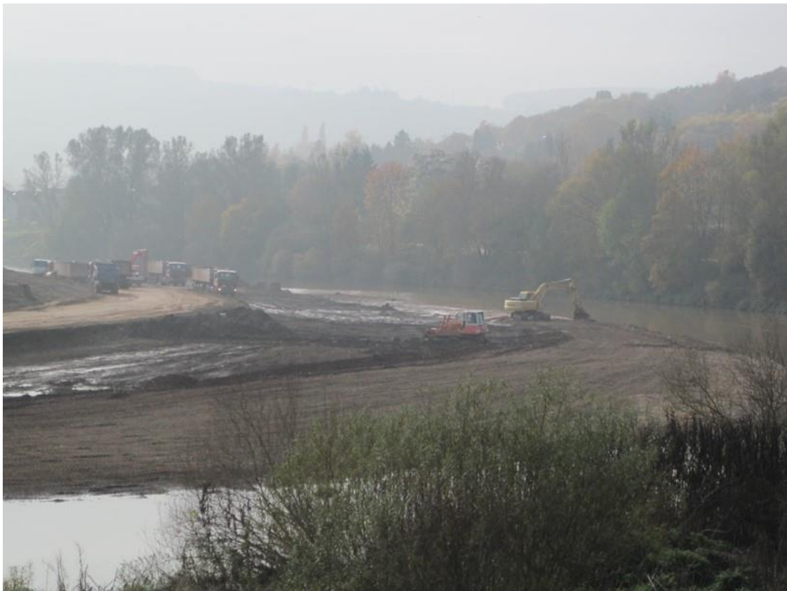
Illustration 24: Mesure anti-crue à orientation écologique à Steinheim-Ralingen pendant les travaux
